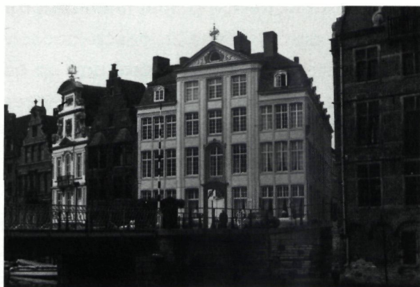
Restauratie : 'De Vijfsterren' Gent
