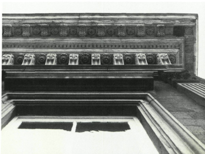
De monumentale 125 cm overkragende kroonlijst van Stellingwerff (foto F. Somers)
