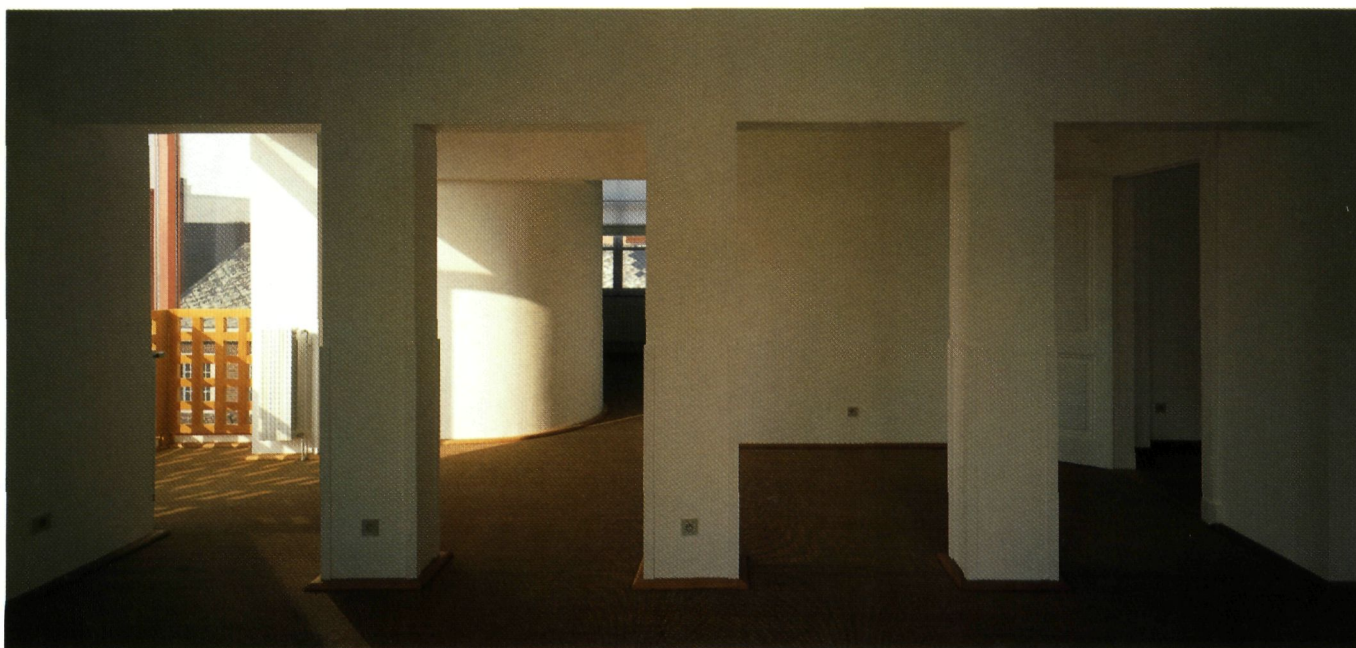
De zijdelingse ruimten zijn permanent met de centrale gang verbonden door de opengewerkte scheidingsmuren (foto G. Charlier)
