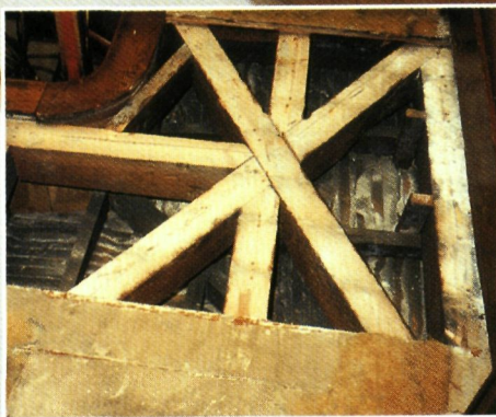
Strukturele polymeerchemische restauratie "Huis Horta Brussel"
