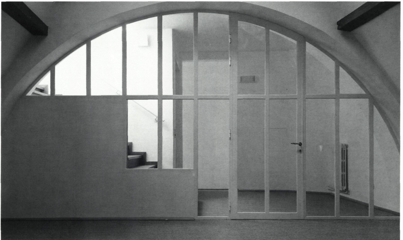
Via de ontlastingsboog in de achtergevel van Stellingwerff , werd een verbinding gerealiseerd met de zolderruimte van het Waardenhof (foto G. Charlier)
