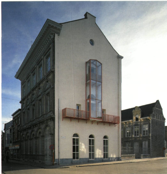
Stellingwerff-Waardenhof na de restauratiewerken (foto G. Charlier)
