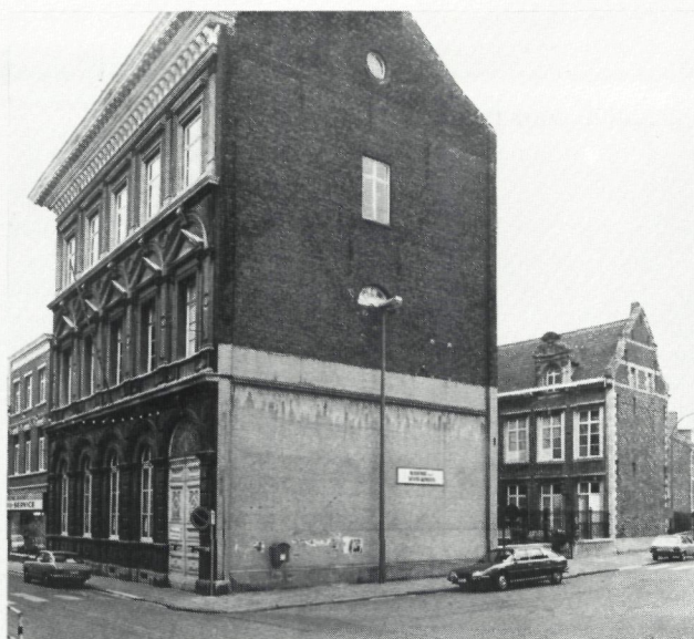
Het 19de-eeuwse Stellingwerff met voorgevel in neo-Venetiaanse renaissancestijl, vóór restauratie. Op de overwegend blinde zijgevel zijn nog sporen merkbaar van de zadeldakvorm van de afgebroken huizenrij (foto F. Somers)
