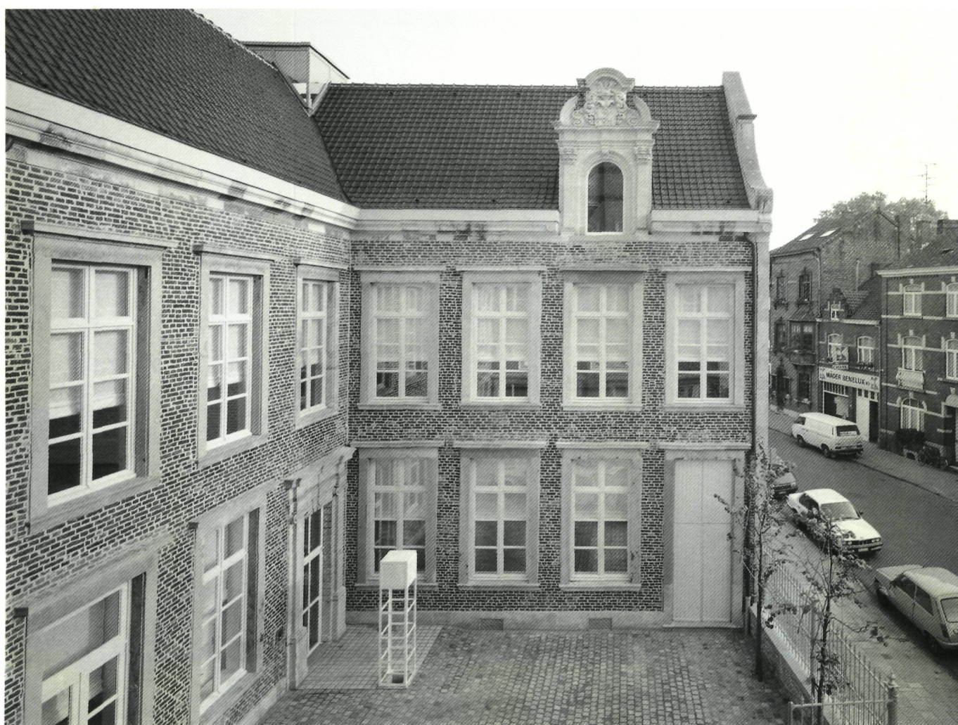
De binnenkoergevels van het Waerdenhof, na de voltooiing van de renovatiewerken. Vermeldenswaardige details zijn enerzijds de kubusvormige daklantaarn op de kruising van twee daken en anderzijds de vernieuwde, mergelstenen dakkapel (foto G. Charlier)
