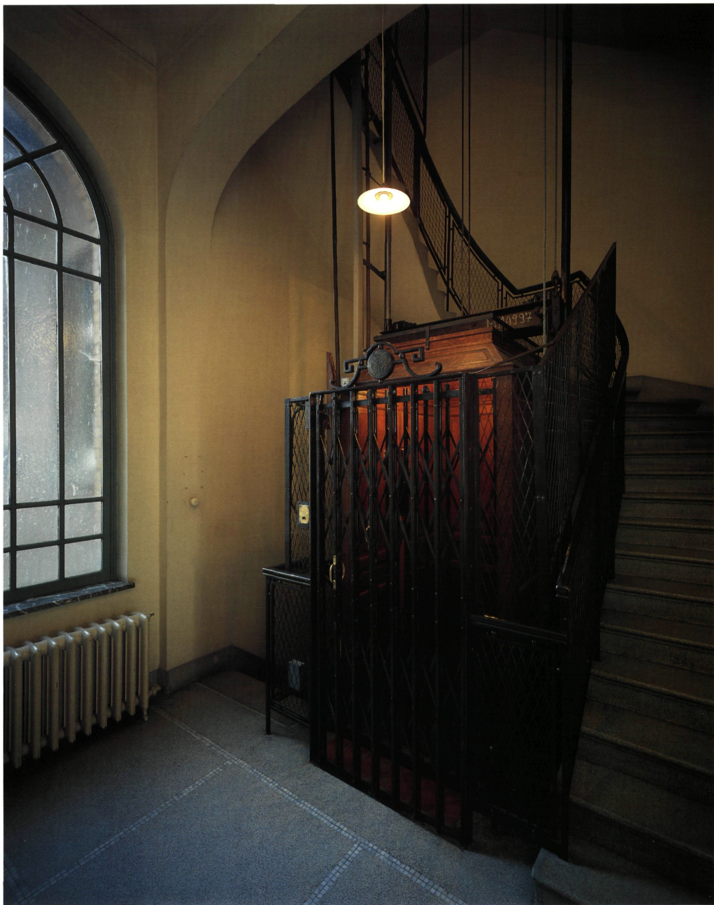
Lift van het merk Otis, bouwjaar circa 1925, Molièrelaan 250, te Ukkel (foto G. Charlier)
