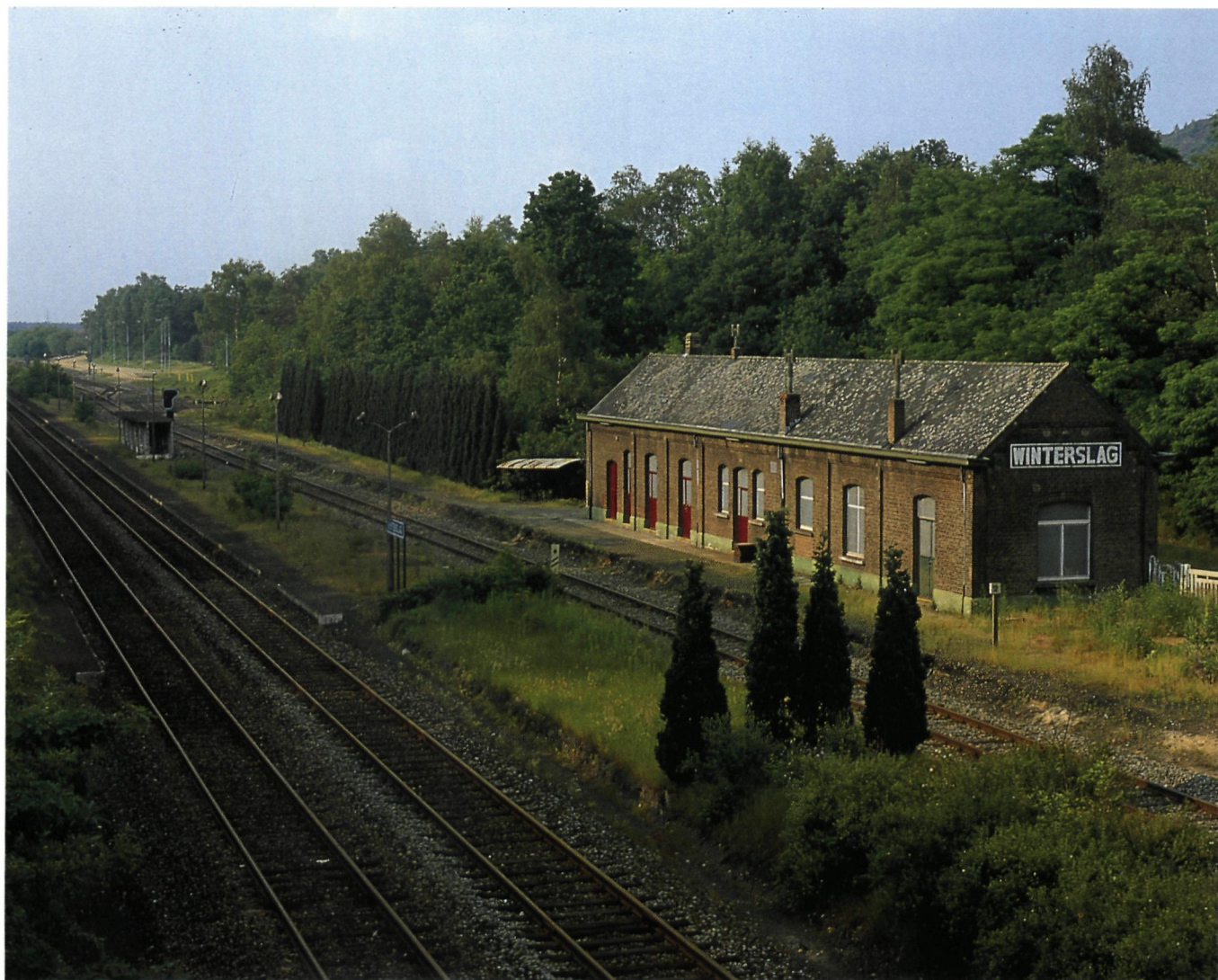
Zicht op de diepe spoorwegbedding, die de oude en de nieuwe cités scheidt, en het mijnwerkersstation van Winterslag. Nadat de mijn reeds vóór W.O. I een eigen verbinding aangelegd had voor Bolwijk, kreeg ze respectievelijk in 1923 en 1925 een definitieve verbinding met Houhalen en Hasselt-Maaseik (de "Genkse kolenlus"). De typische houten mijnstations van Beringen en Eidsden sneuvelden de laatste 10 jaar door brand (foto B.V.D.)
