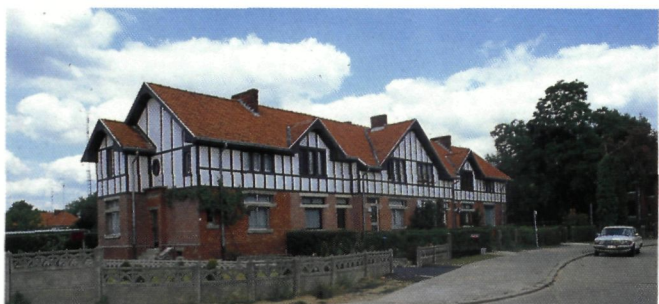
Zeswoonst van het type I6 aan het zogenaamde Rond Punt langs de Koolmijnlaan te Zolder. Hier werden vanaf 1913 de eerste mijnwoningen gebouwd ... 17 jaar v or de eerste kool kon bovengemaal worden. Dergelijke blokken die varieerden van vier- tot achtwoonsten, vinden we ook in de andere straten van cit  Berkenbos terug (foto B.V.D.)
