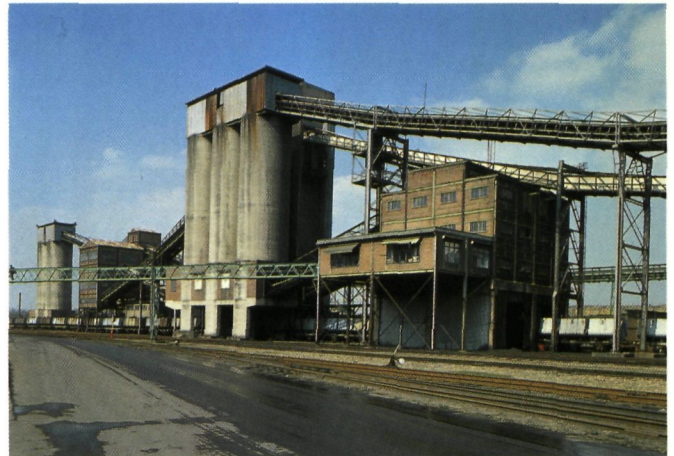
Vertrouwd beeld voor de 'bovengronders' van Zolder met de enorme meng- en laadbunkers met hun lange transportbanden naar de kolenwasserij. De kool van Zolder wordt onder meer gemengd met Duitse Ruhrkolen om aan de noden van verbruikers te voldoen (foto E.D.)
