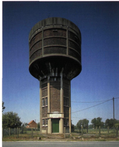
Boom, Nachtegaalstraat (1936, 260 m 3 ): betonnen Intzekuip op gesloten prismati- sche voet in skeletbouw; sterke overkra- ging van het kuipgedeelte (foto O. Pau- wels)
