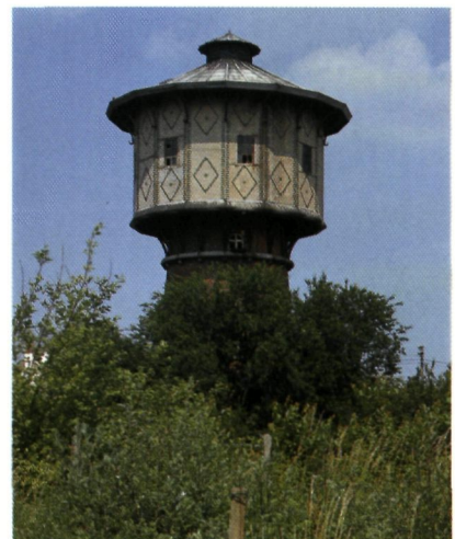
Eigenbrakel (na 1900): de Intzekuip is hier omgeven door een veelhoekige mantel uit profielijzer en baksteen (foto O. Pauwels)
