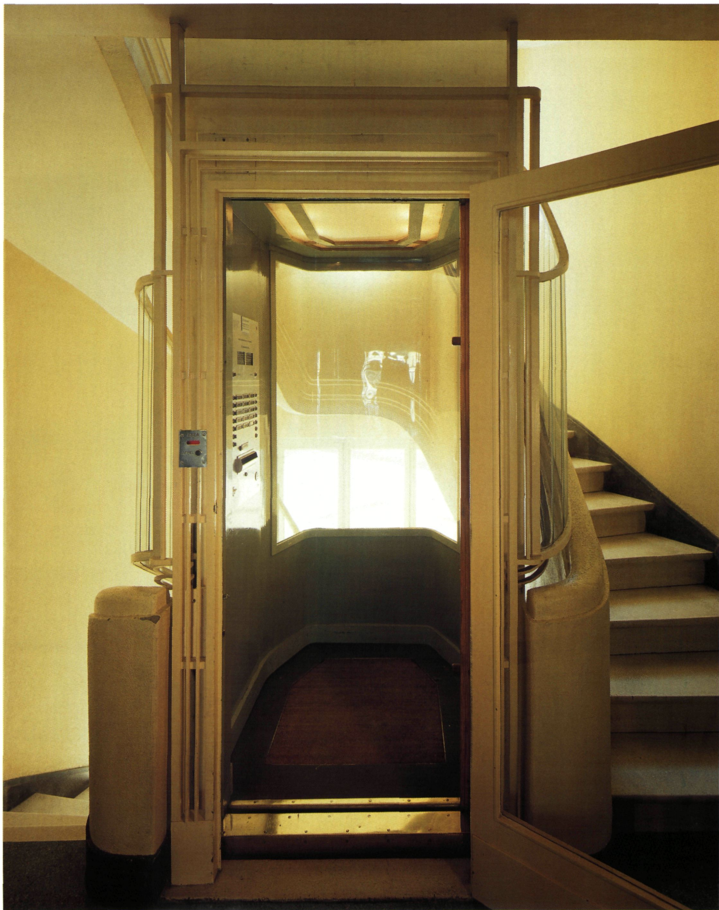
Glazen bordesdeuren (architect J. Delhaye) tot een lift van het merk Marien-ASEA, bouwjaar 1951, Jupiterlaan 93, te Vorst (foto G. Charlier)
