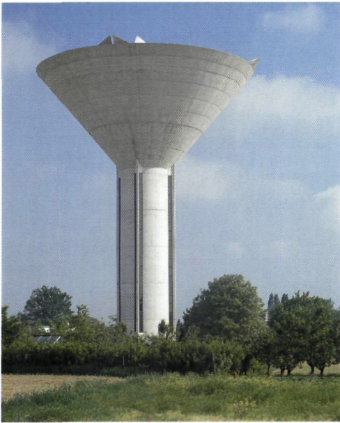
Bilzen, Weg nr. 128 (1985, 1600 m 3 ): omgekeerd-kegelvormige kuip in voorgespannen beton, op smalle schacht (foto O. Pauwels)
