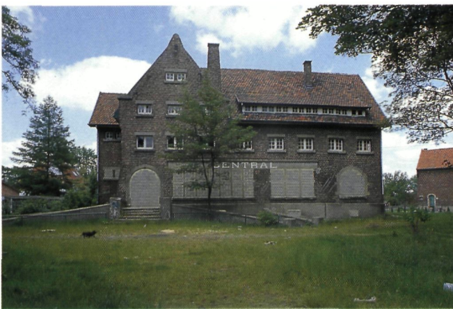
Het Hotel Central (1923) aan de Nachtegaalstraat heeft als elite-hotel duidelijk betere tijden gekend. Onlangs werd de benedenverdieping dichtgemetsel door het Vlaams Woningfonds, na protest van de wijkbewoners over verkrotting en vandalisme (foto B.V.D.)
