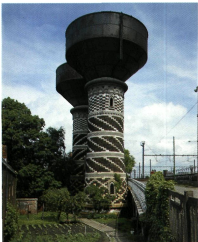
Antwerpen, Ooststation (1898, volume onbekend): onbeklede ijzeren Intzekuip op gesloten voet; sterke overkraging van het kuipgedeelte (foto O. Pauwels)
