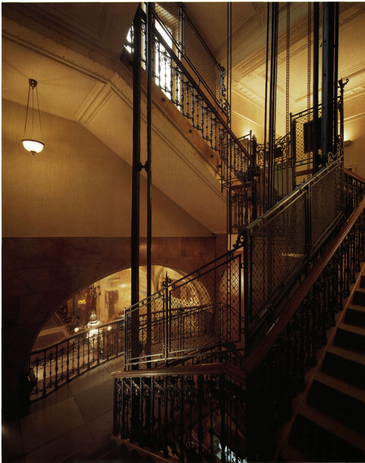
Liftschacht — merk Otis, bouwjaar circa 1920 — in de trapzaal van het Hotel Metropole, de Brouckèreplein 33-35, te Brussel (foto G. Charlier)
