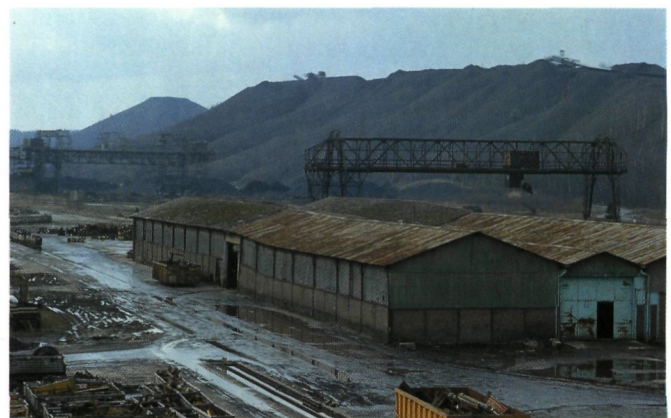
Een voorbeeld van 'mijngebouwen' die duidelijk zichzelf overleefd hebben en zonder meer kunnen gesloopt worden (reeds zijn!). Op de achtergrond de tweede en vooraan de derde terril die vermoedelijk zullen gebruikt worden als dumpingsgrondstof om de tussen- en achterliggende grindontginningsvijvers op te vullen (foto E.D.)
