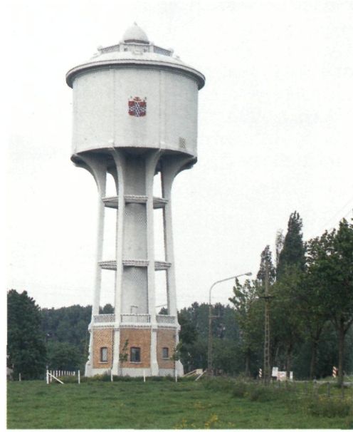
Ieper, Dikkebusseweg (1925, 600 m 3 ): betonnen vlakbodemkuip op open voet (betonbalken); vroege betonbouw, tweede generatie (foto O. Pau- wels)
