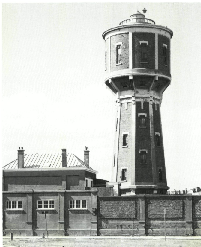
Oostende, Victoriaal (Opexwijk) (1932, 600 m 3 ): verbeterde skeletbouw met intzekuip op piramidale voet; typische contrasterende sierelementen (foto O. Pauwels)
