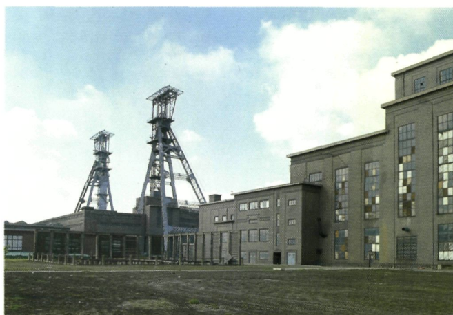
Mijnzetel Houthalen. Zicht vanuit het Noorden met (van rechts naar links) de elektrische centrale, het ophaalmachinegebouw, de losvloergebouwen en schachtbokken 2 en 1. Vooraan links de restanten van de rechthoekige betonnen omheining van een fonteinkoelsysteem, ter vervanging van een koeltoren (foto E.D.)
