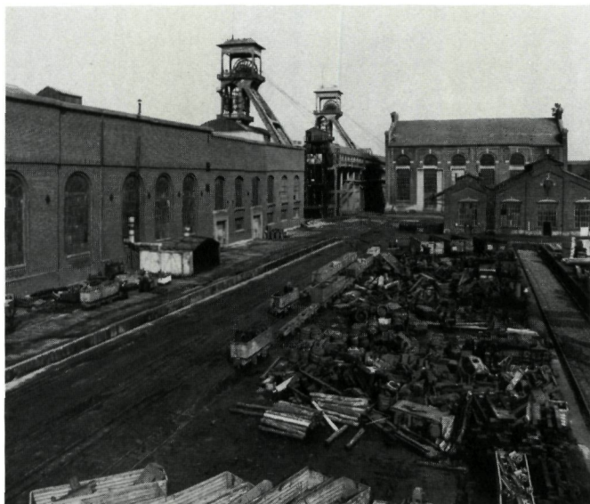
Metaalpark te Eisden met gerecupereerd ondergronds materiaal, vlak na de sluiting. Momenteel wordt volop gesloopt en moeten de werkhuizen (links), kolenwasserij en passerels achter en tussen de betonnen schachtbokken en het vroegere pompenhuis (rechts vóór) plaats ruimen voor nieuwe bestemmingen van het mijnsterrein (foto E.D.)
