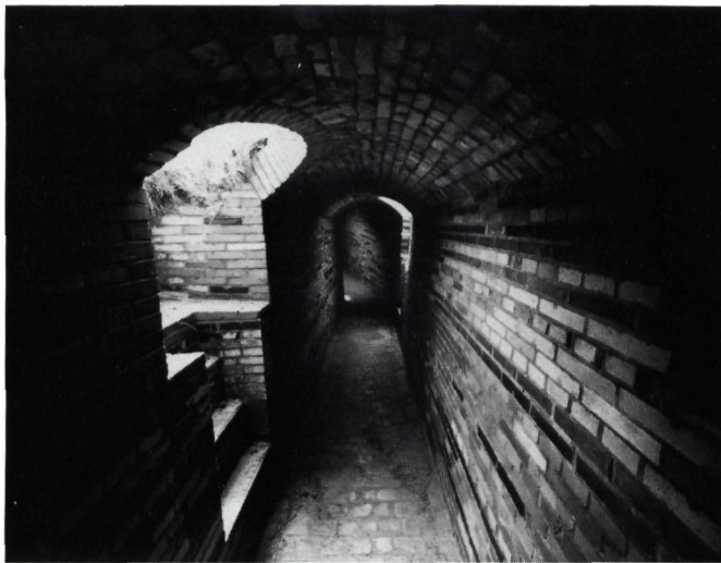
Raversijde, Koninklijk Domein. Bakstenen loopgraaf uit WO II (foto G. Charlier)
