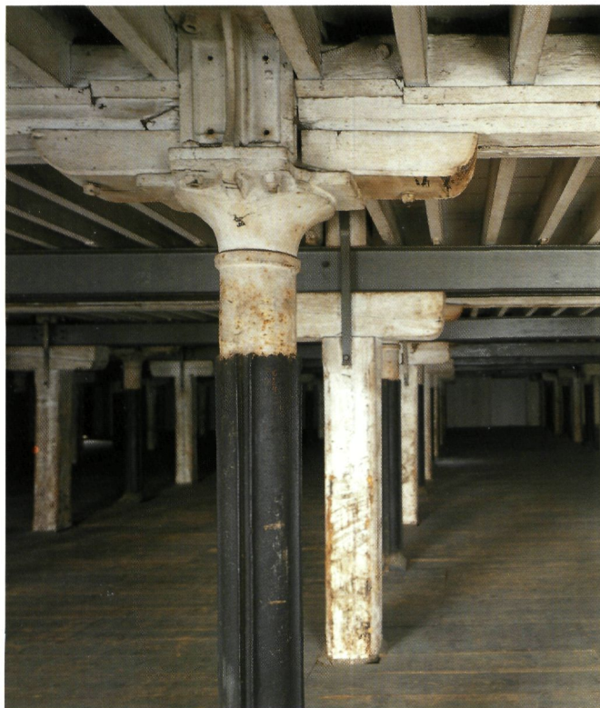
Pakhuis Sint-Felix. Detail van de gietijzeren pijlers en de toegevoegde ijzeren I-liggers (foto O. Pauwels)
