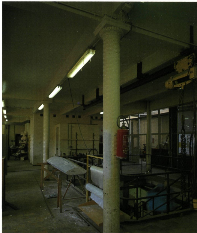
Voormalig pakhuis van de Compagnie Maritime Belge (thans HAIR). Detail van de gietijzeren kolommen (foto O. Pauwels)
