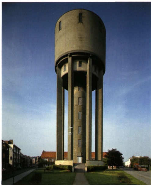
Gent, Maïsstraat (1955, 1000 m 3 ): betonnen vlakbodemkuip op open voet met centrale schacht (foto O. Pauwels)
