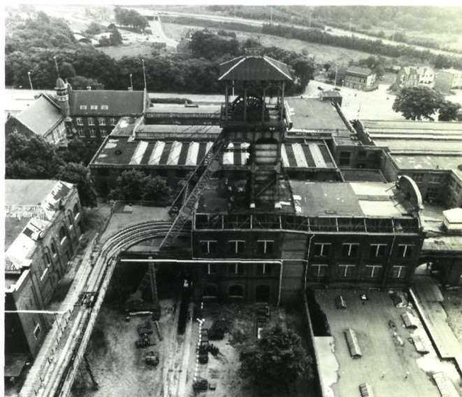
Zicht op de originele schachtbok II (1916) vanaf de nieuwe hoge schachtbok (1962-1963) te Winterslag. Het losvloergebouw verkeert in een bedenkelijke staat en de prachtige ophaalmachines en elektrisch schakelbord eisen dringende onderhoudswerken (foto E.D.)
