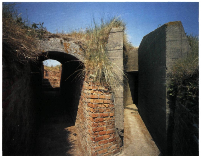
Raversijde, Koninklijk Domein. Met beton overdekte loopgraven uit WO II (foto G. Charlier)
