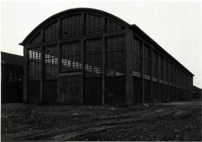
Eisden. Eén van de drie typische gewapend-betonnen gebouwen (betonfirma Monnoyer die een bijzondere relatie onderhield met deze mijnzetel). Inmiddels werd ook dit gebouw gesloopt (foto E.D.)
