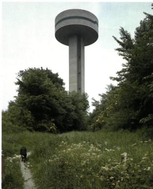
Vilvoorde, Romeinse Steenweg (Koningslo) (1978, 1000 m 3 ): cilindrisch kuipgedeelte met vlakke bodem, sterk overkragend op een smalle schacht; paddestoelvorm (foto O. Pauwels)
