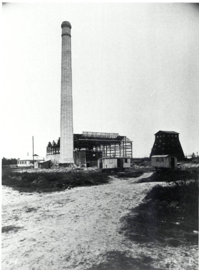
Vorbereidende schachtafdiepijngswerken te Zolder op 4 februari 1914, met het eerste ketelhuis in aanbouw en één van de houten afdiepijngstorens achteraan. Deze betonnen Monnoyerschouw van Zolder (een vroeg systeembouwexperiment van de bekende Brusselse betonfirma) is momenteel nog de enige die op de Limburgse mijnzetels overeind staat. Door de invoering van de enorme rechtopstaande stoomketels vanaf de jaren 1930 met individuele 'dakuïllaat' werden ze immers overbodig (archieffoto P.M.I.E.)
