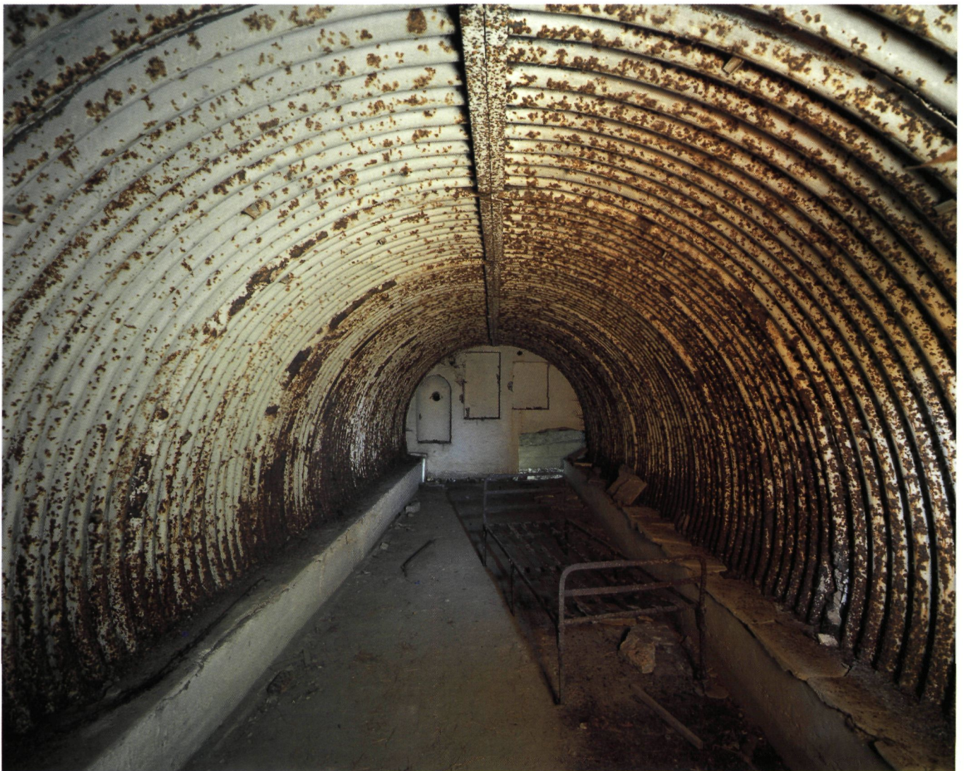
Raversijde, Koninklijk Domein. De centrale schuilbunker voor manschappen uit WO I (foto G. Charlier)
