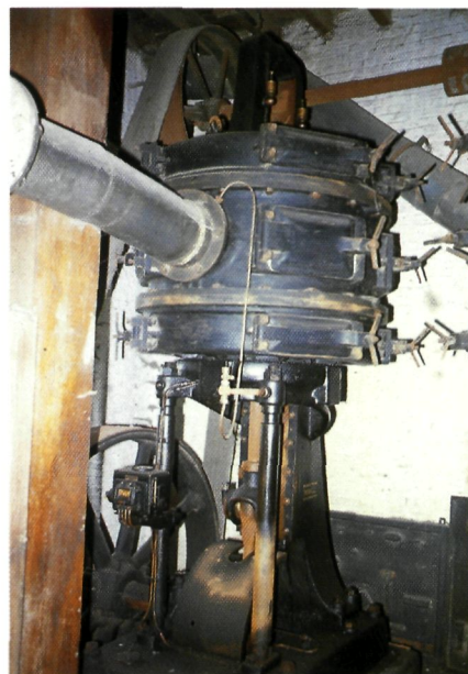
en stoomaandrijving in de maalderijen Rypens te Boom (eigen foto's)
