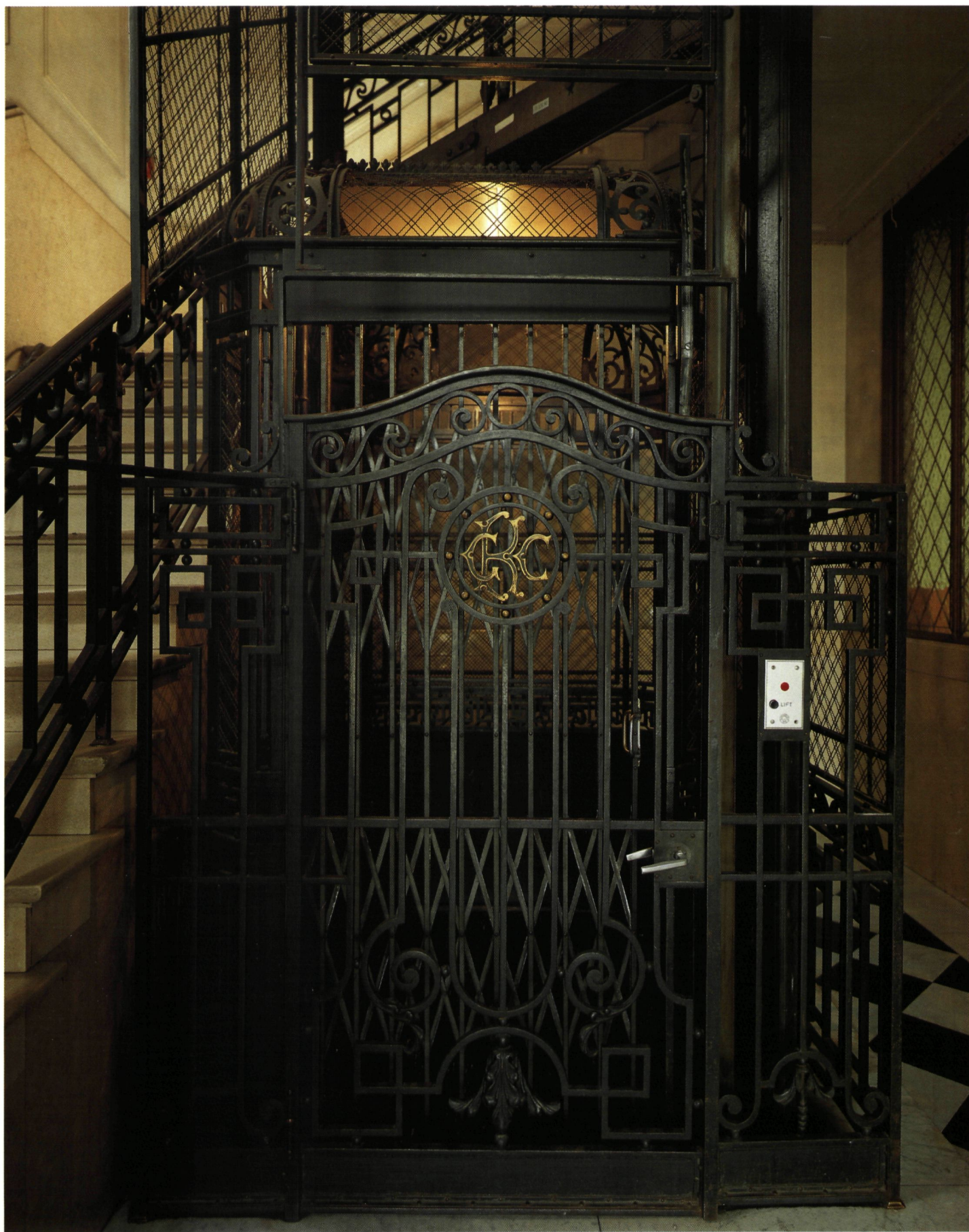
Toegang tot een lift van het merk Schindler, kenletter CCK (Comptoir Commercial Kreglinger), in De Spiegel, het voormalig Gildenhuis van de Handboogglide (heropgericht in 1903-1904, thans Indosuez Bank België), Grote Markt 9, Antwerpen (foto G. Charlier)
