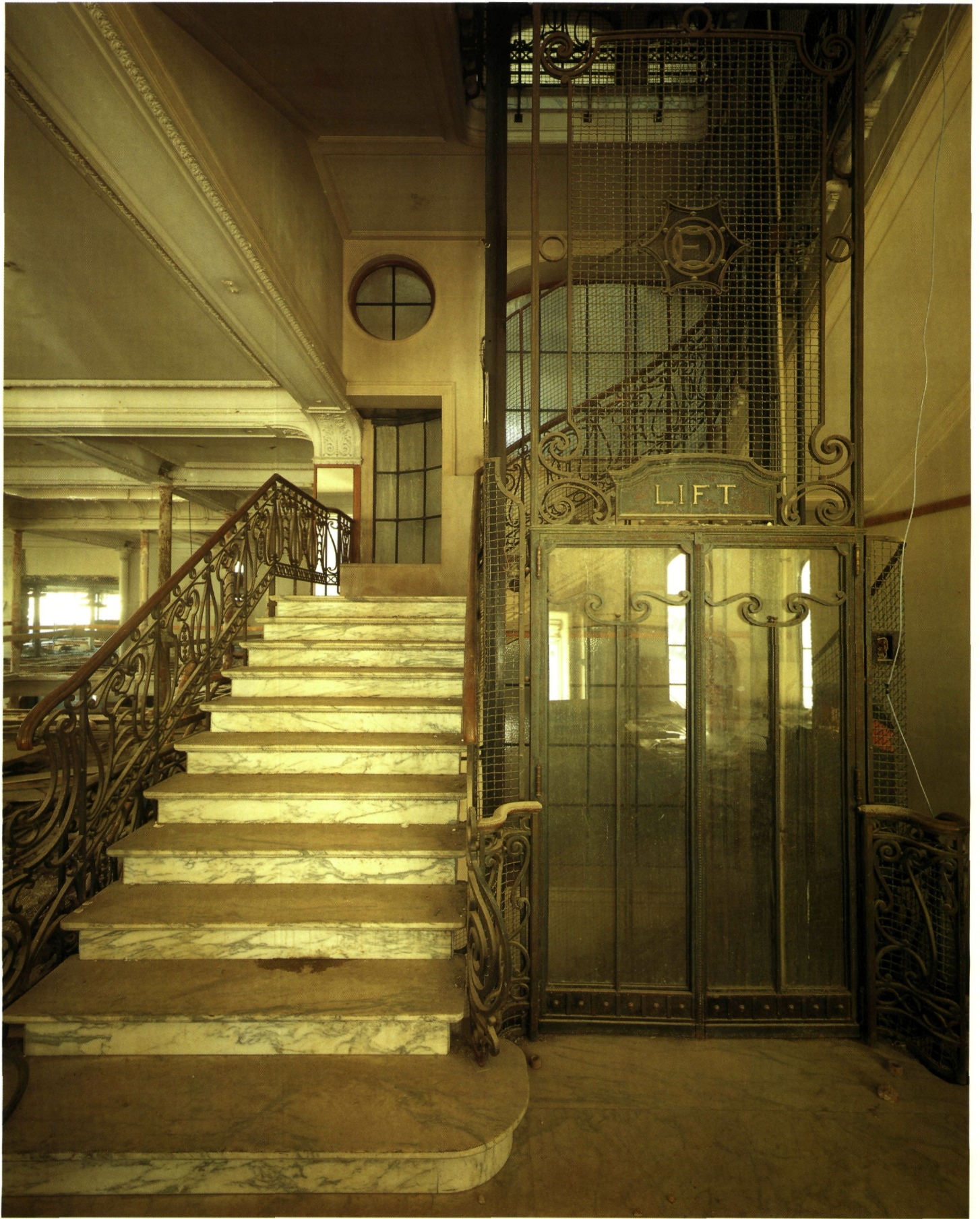
Liftschacht — merk Schindler, bouwjaar circa 1913 — in het voormalig warenhuis Old England, Koningsplein 13, te Brussel (foto G. Charlier)
