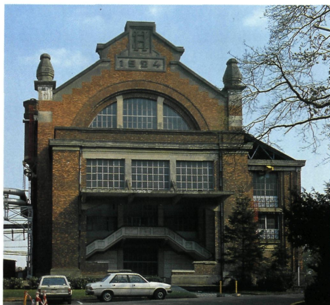
Voorgevel van de elektrische centrale van Zolder met bovenaan hun logo en bouwdatum 1924. Samen met het extratiemachenegebouw (zie foto op frontpagina) vertoont deze centrale nog een duidelijke prestige-architectuur waar de directie na de brand van 1925 en bijkomende schachtproblemen zal vanaf zien (foto E.D.)
