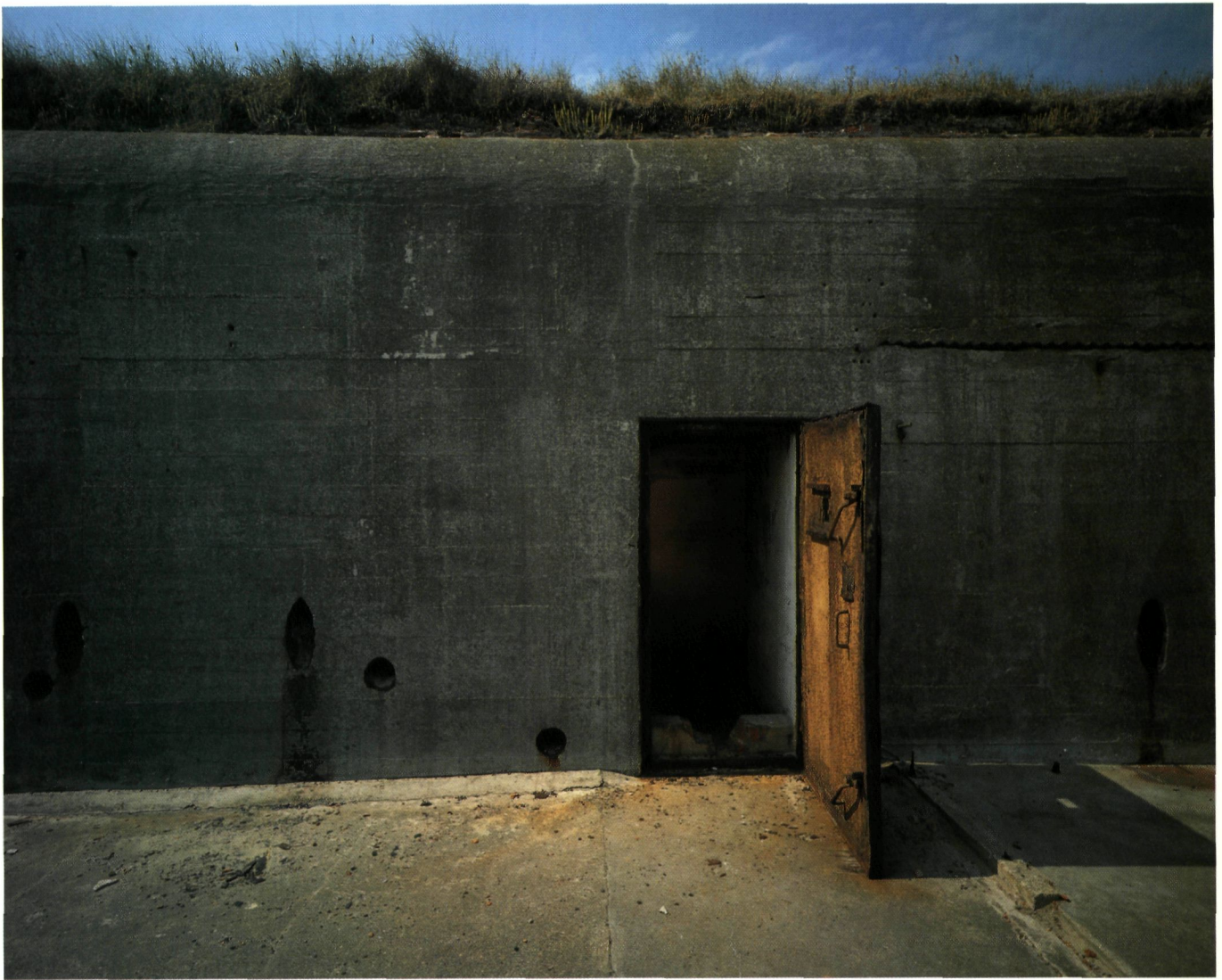
Raversijde, Koninklijk Domein. Flankeringsbunker van de Batterie Tirpitz uit WO II (foto G. Charlier)
