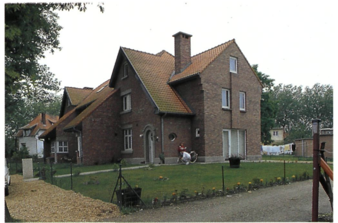
Een onlangs (1988) door het Vlaams Woningfonds gerenoveerde vijfwoonst (1924) in de Duivenstraat. Eén positief voorbeeld dat véél navolging verdient ! (foto B.V.D.)
