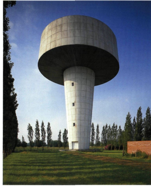
Sint-Amands, Heidestraat (1980, 1500 m 3 ): kegelvormige kuip in voorgespannen beton, op omgedraaid kegelvormige voet (foto O. Pauwels)
