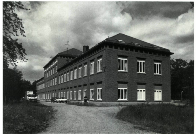
De eerste hoofdburelen van Eisden (1909-1912) het oudste mijngebouw van het Kempisch bekken. Het gebouw werd gerenoveerd tot O.C.M.W.-tehuis voor daklozen en kan als voorbeeld gesteld worden van een daadwerkelijk herwaarderingsbeleid (foto E.D.)
