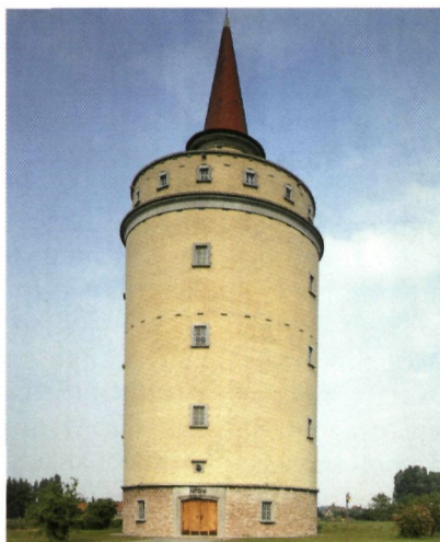
Waregem, F. Rooseveltlaan (1963, 650 m 3 ): betonnen Intzekuip met draagstructuur opgenomen in cilindrische ommanteling; typisch streekgebonden architecturale vormgeving; zuilvorm (foto O. Pauwels)
