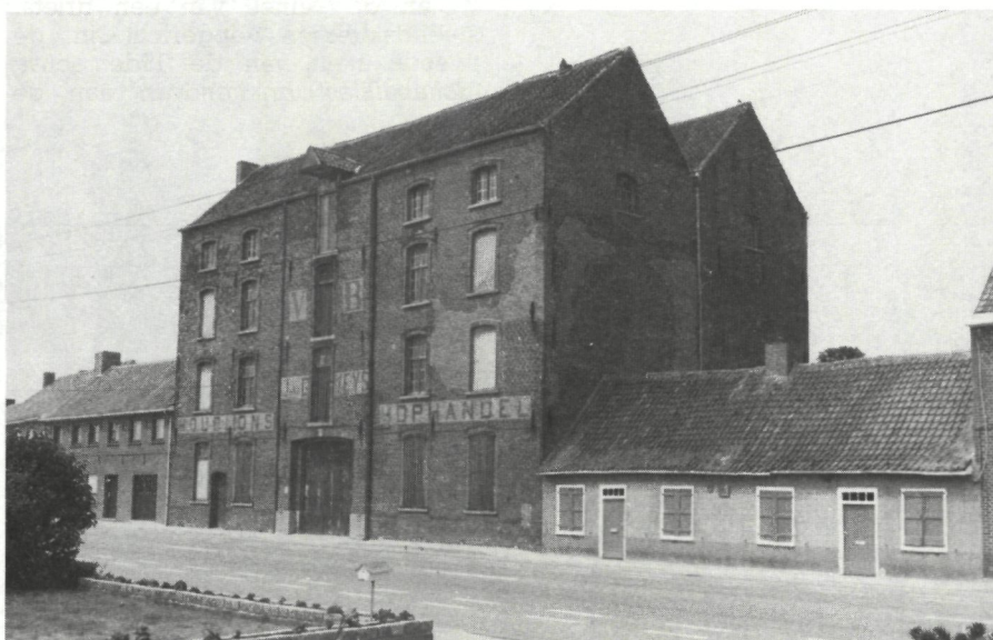
Vlamertinge. Poperingseweg nr. 322. Voormalig hopmagazijn
