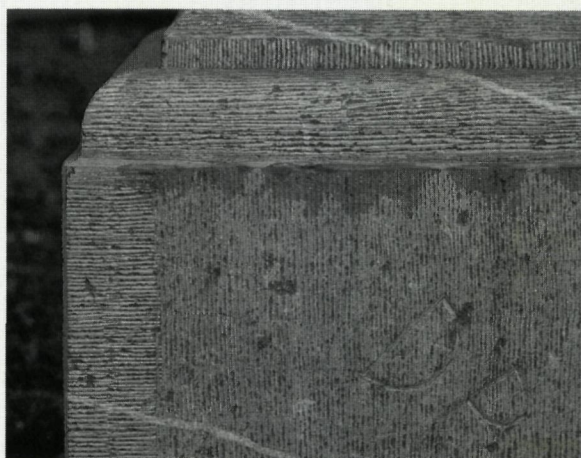
Het merk DP, na restauratie (foto P. Van den Broeck)
