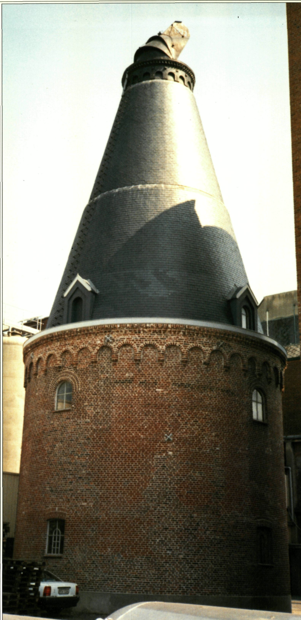
Ast van de Brouwerij Rodenbach na restauratie
