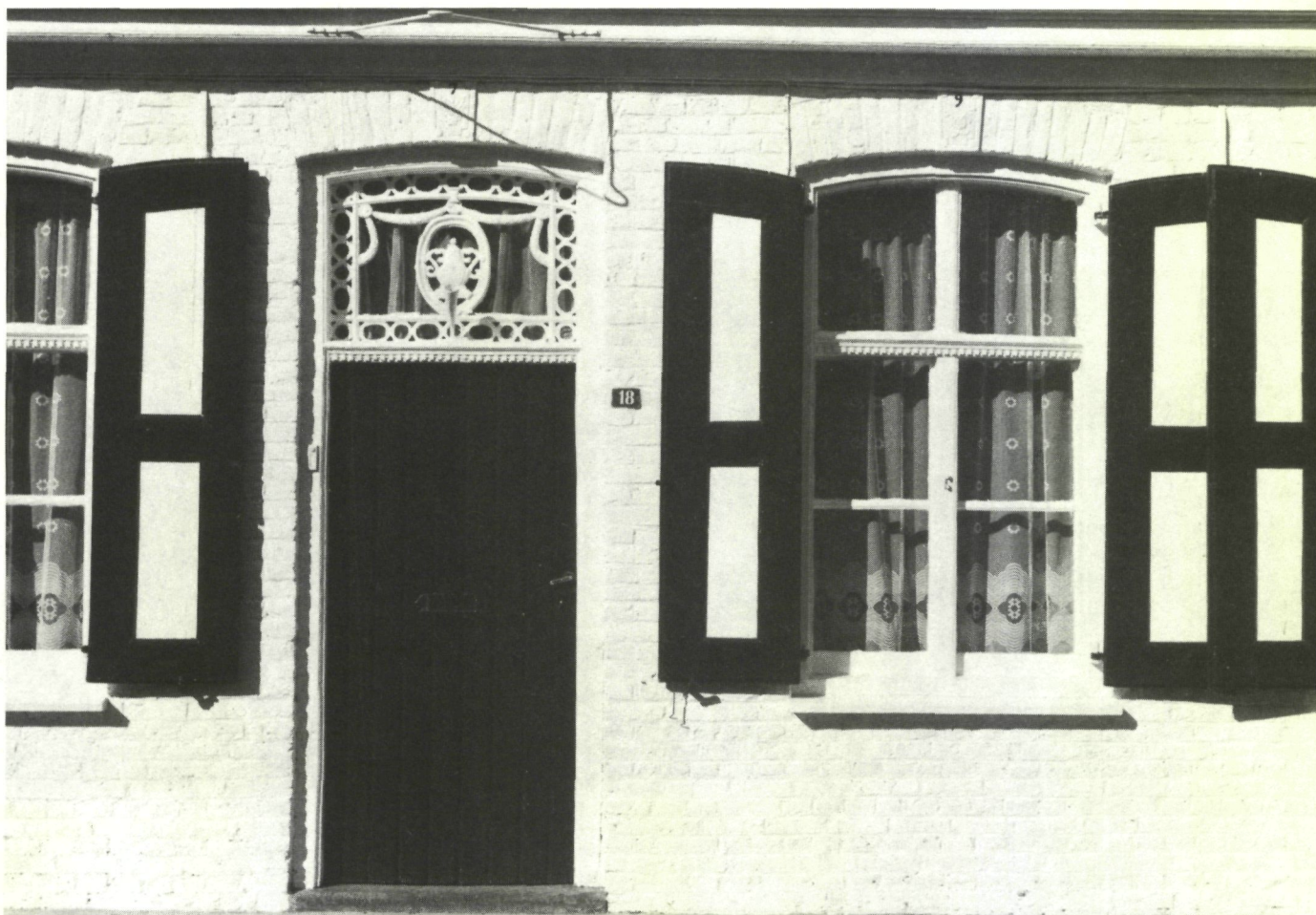
Watou. Vijfhoekstraat nr. 18. Kozijnconstructies (1799)
