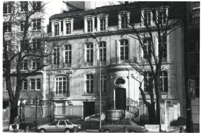
Het Herenhuis Vaxelaire, Sterrekundelaan, Brussel. Beschermd monument. Begin 19de eeuw. REMAL 13 : chemische gevelreiniging
