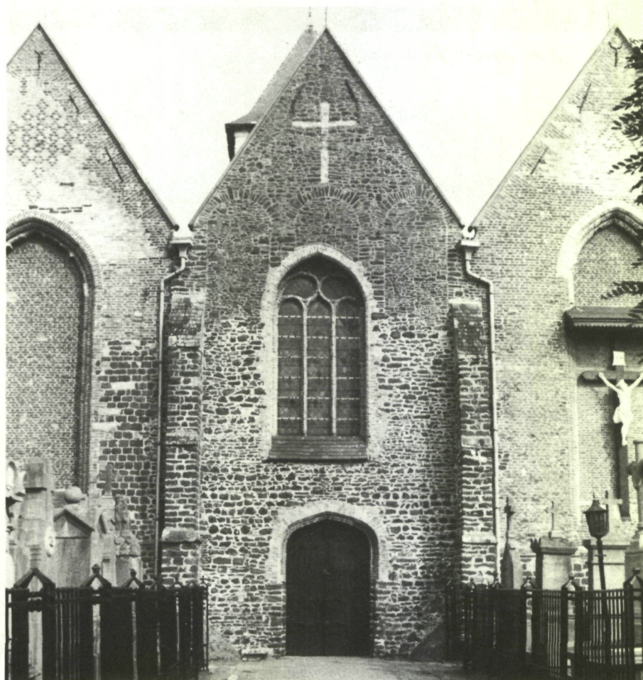
Reningelst. Reningelstplein. St.-Vedastuskerk. Centrale westgevel
