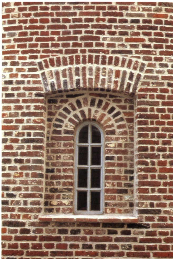
Vernieuwd schrijnwerk, naar het oorspronkelijk model (eigen foto)
