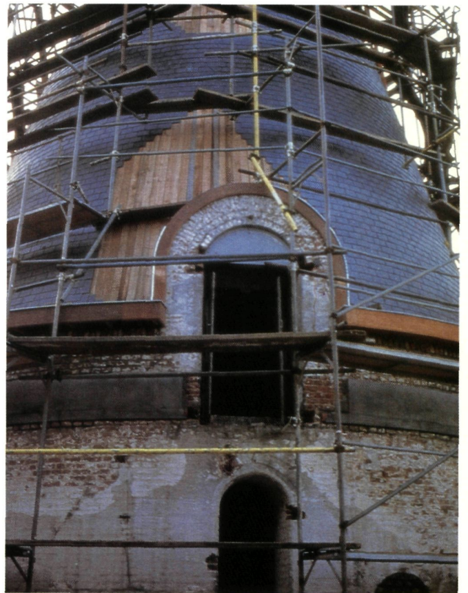
Diezelfde doorgang bij het bekleden van de kegel (eigen foto)
