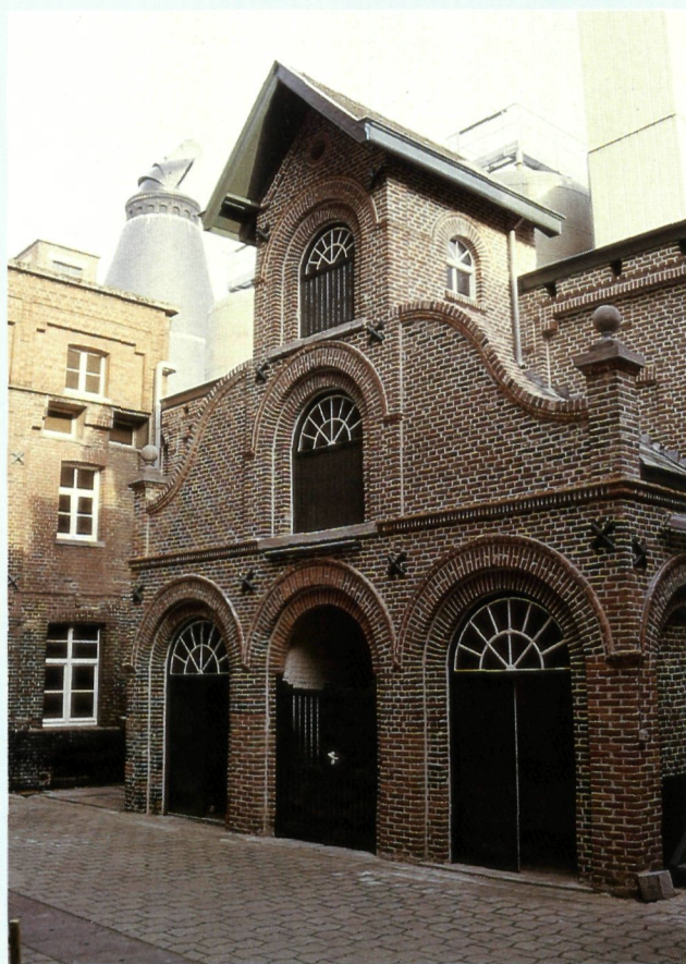
Ook het voormalig inkomportaal van de mouterij werd hersteld. Weliswaar bleek de schade hier veel minder ernstig. Het zou volstaan de meest verweerde stenen te vervangen, een belangrijke barst in te binden en het corroderende zinkwerk te vernieuwen (eigen foto's)
