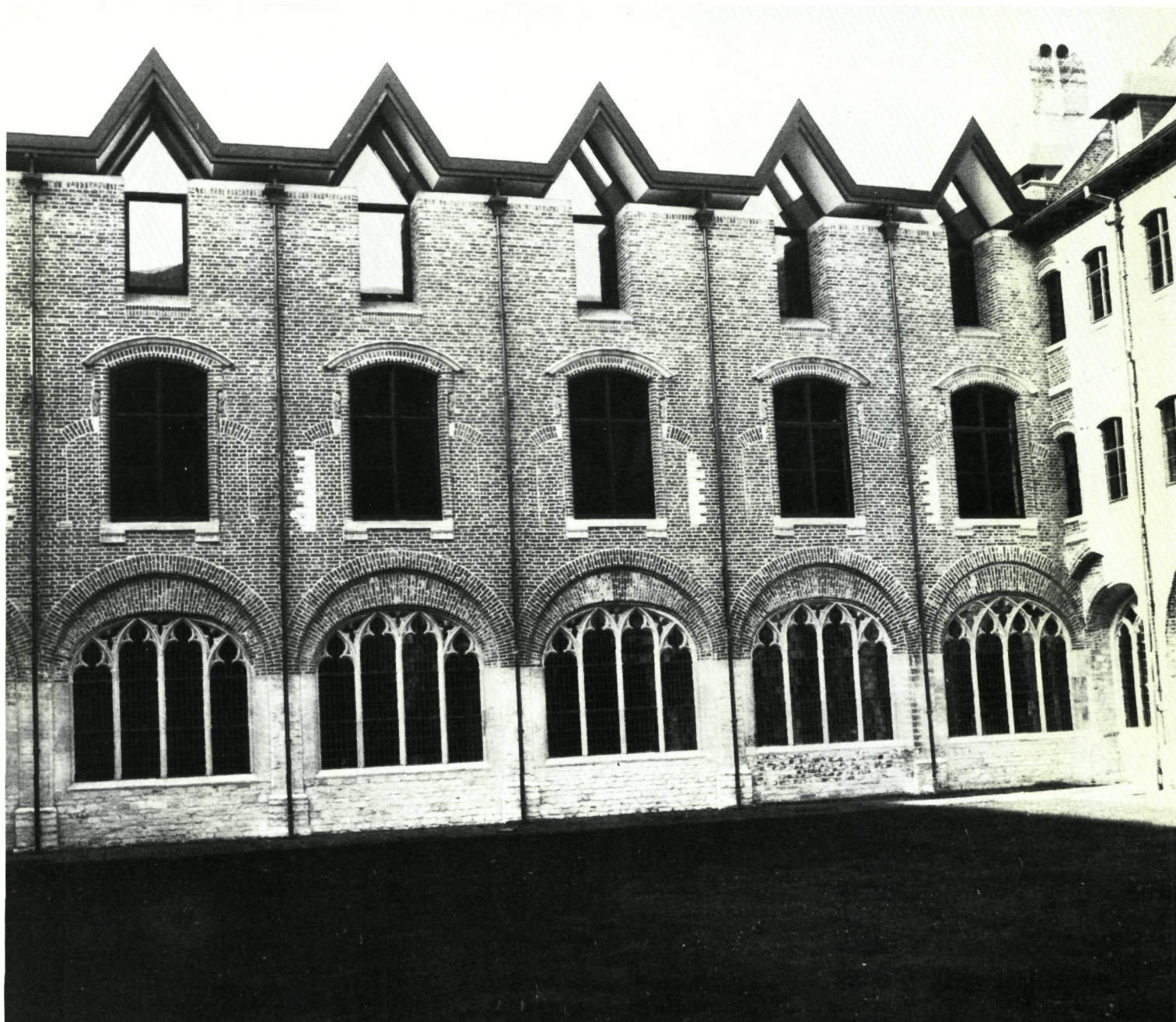
Restauratie van de Rijksuniversiteit "HET PAND" te Gent.
