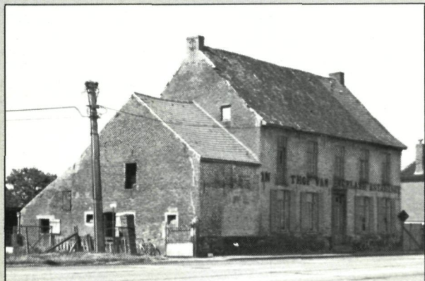
Toestand in juli 1977 vóór de restauratiewerkzaamheden (foto B.M.L.).
