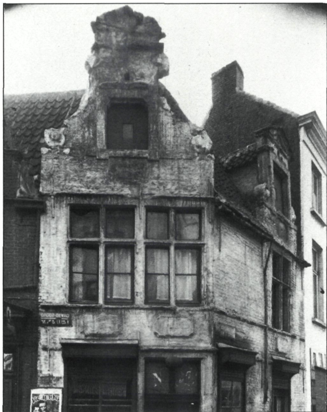
Gent, Gewad 33. Toestand in 1940. Op de klokgevel is het fronton nog aanwezig (foto archief van de Stedelijke Commissie voor Monumenten en Stadsgezichten).
