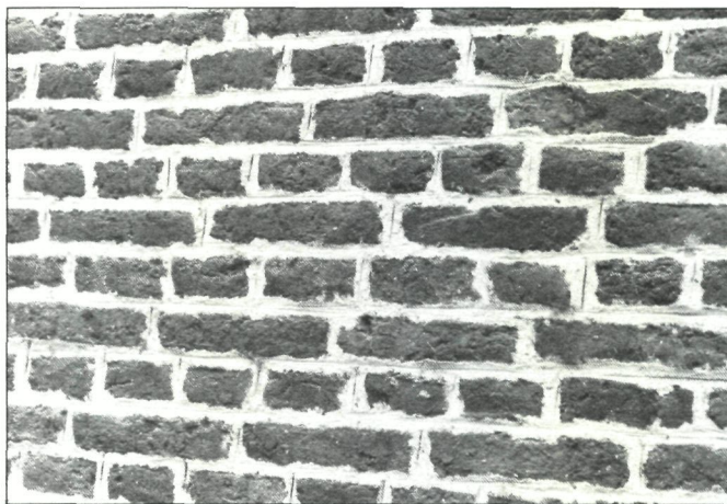
Op een beschutte plaats van de zijgevel — op de zolder boven de lagere aanbouw — werd dit onverweerd parament aangetroffen, zoals het er oorspronkelijk moet hebben uitgezien. Bemerkt de 'dag' die in de voegen getrokken werd (foto B.M.L.).
