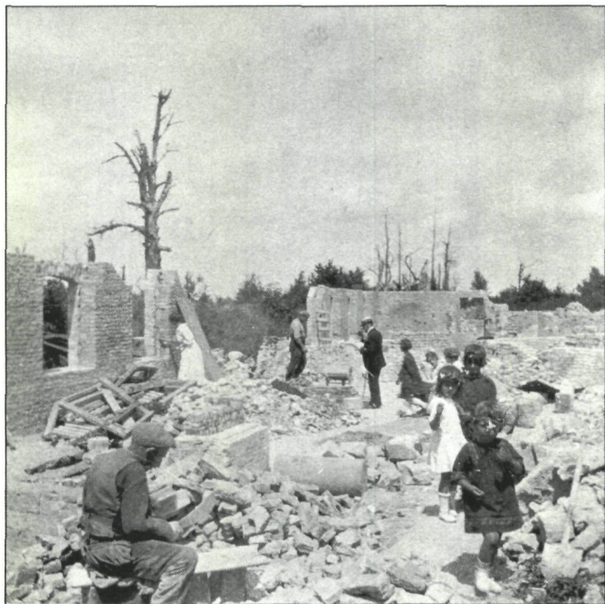
1921: het puin wordt tot biksteen geslagen om nadien in het beton verwerkt te worden (foto familiearchief le Fevere de ten Hove - Blerot).
