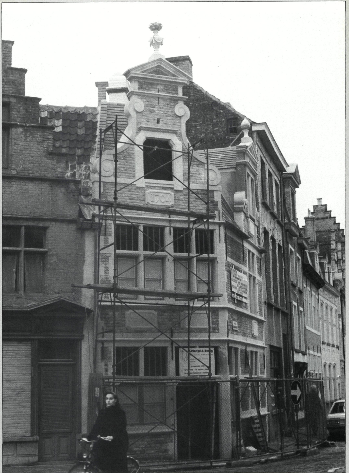
Gent, Gewad 33. Foto genomen in 1985 tijdens de restauratie, voordat de geschilderde gevelafwerking weer werd aangebracht. Een deel van het publiek had liever dit uitzicht bestendig gezien (foto arch. Dirk Steyaert).
