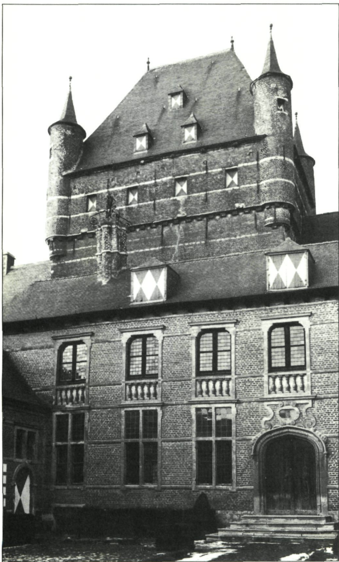
De zware donjon van kasteel 'Bossenstein' in Broechem zou opgetrokken zijn in de 2de helft van de 14de eeuw (foto B.M.L.).
