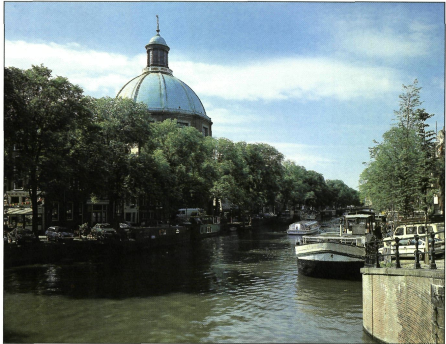
→ 13. Lutherse Kerk, gebouwd door Suys tussen 1822 en 1826
