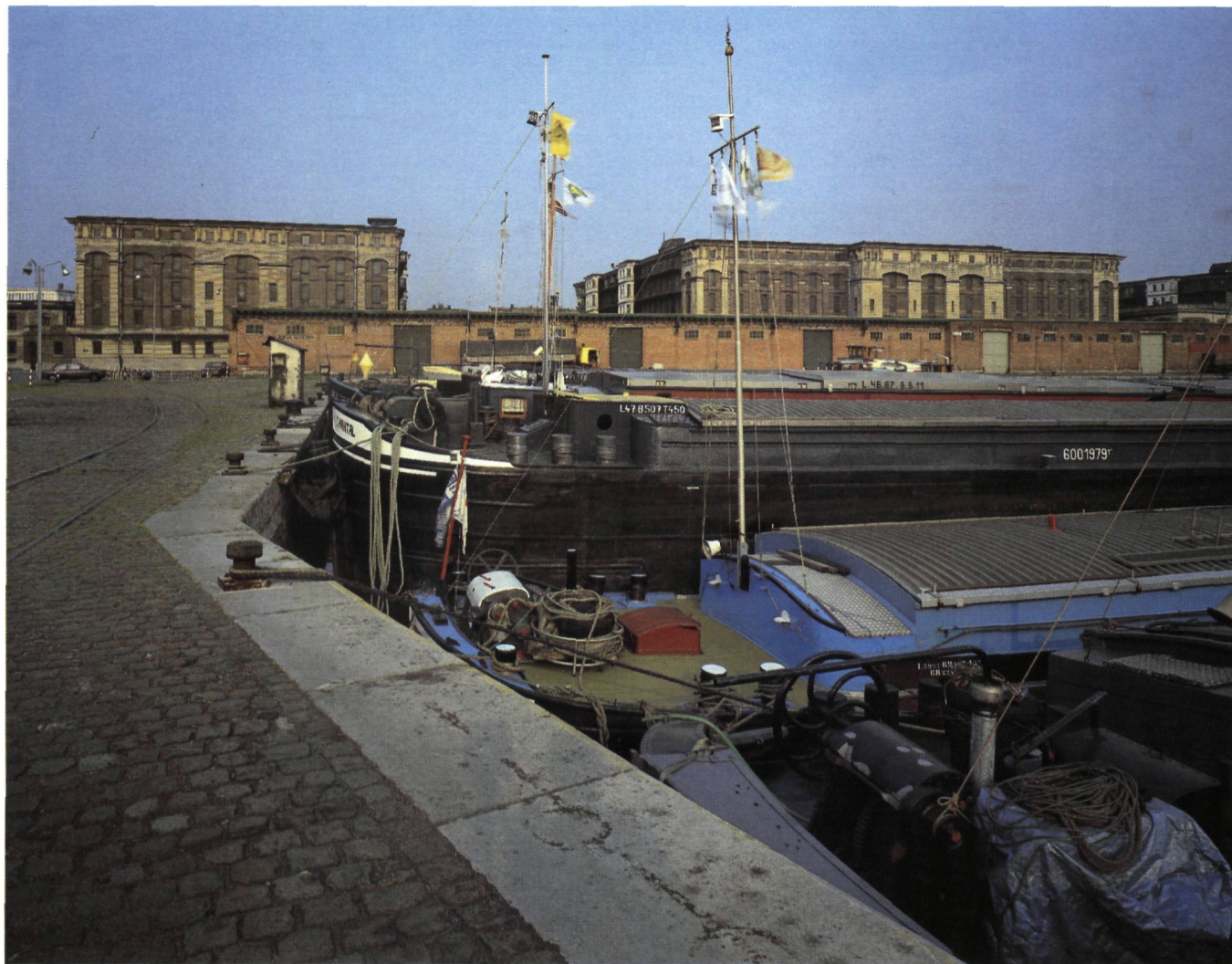
Het heropgebouwde Koninklijk Stapelhuis aan de Entrepotkaai, opgetrokken tussen 1901 en 1906 (foto G. Charlier).
