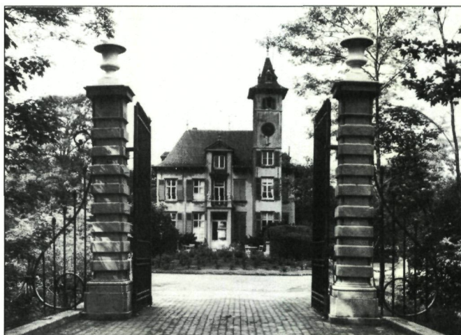
Toegangspoort van het 'Laarhof' in Reet bestaande uit een eenvoudig ijzeren hek tussen twee hardstenen pijlers met siervaas (foto B.M.L.).
