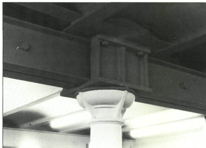
Hessenplein nr. 23. Detail van dubbele I-lijger op gekraagde kolom (foto B.M.L.).
