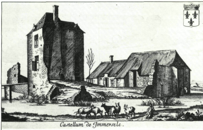
De ruïne van het 'Castellum de Immersele' laat duidelijk zien waaruit een kasteel in oorsprong bestond: een motte, een donjon, een hoeve, een ringmuur en een watergracht. Gravure uit J. Leroy (1694) (foto B.M.L.).
