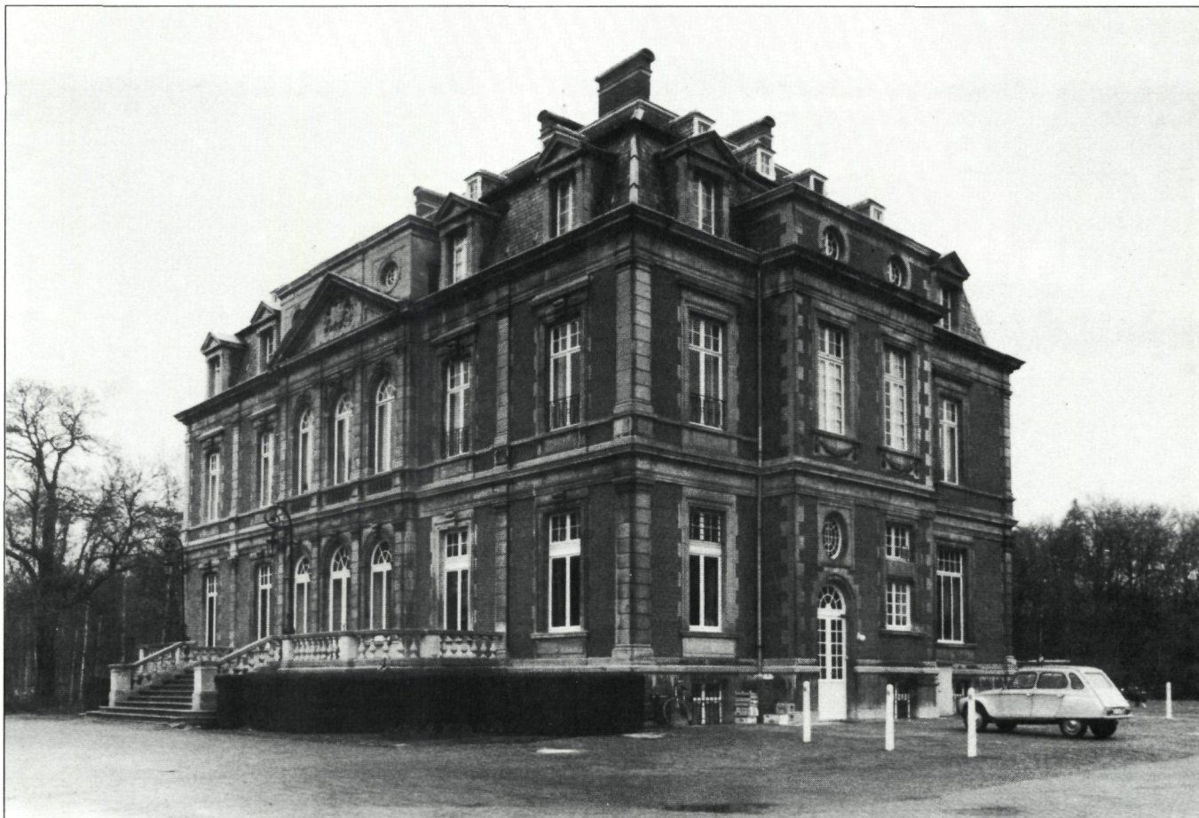
Kasteel 'De Horst' in Schoten; neoclassicistisch kasteel van 1896-1905, nu gebruikt als vormingscentrum voor speelpleinmonitoren (foto B.M.L.)
