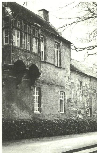
Zottegem, Egmontkasteel: oostgevel met renaissance-erker. (Foto B.M.L.)
