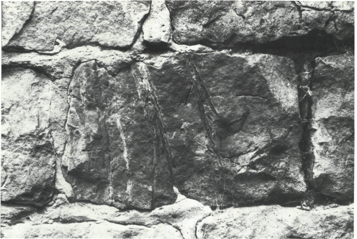
Overlaar, detail van de buitenmuur: kwartsiet met verkiezelde houtfragmenten en wortelsporen.
