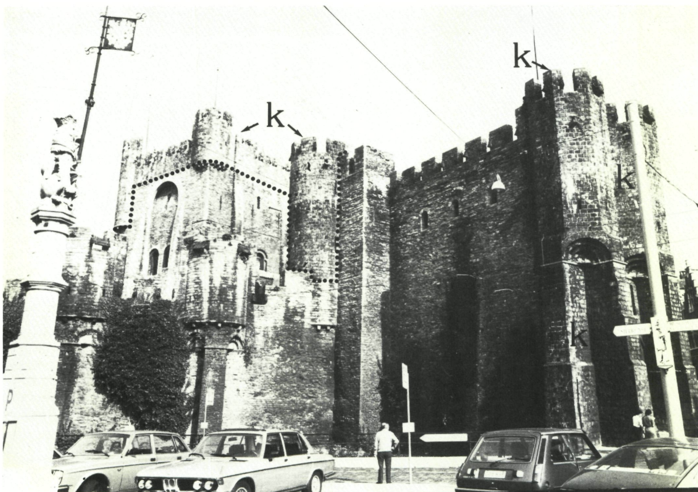
Fig. 7: Het Gravensteen te Gent. De grens tussen het Noordfrans kwartsiet (K) en de Doornikse kalksteen is met een stippellijn aangegeven.
