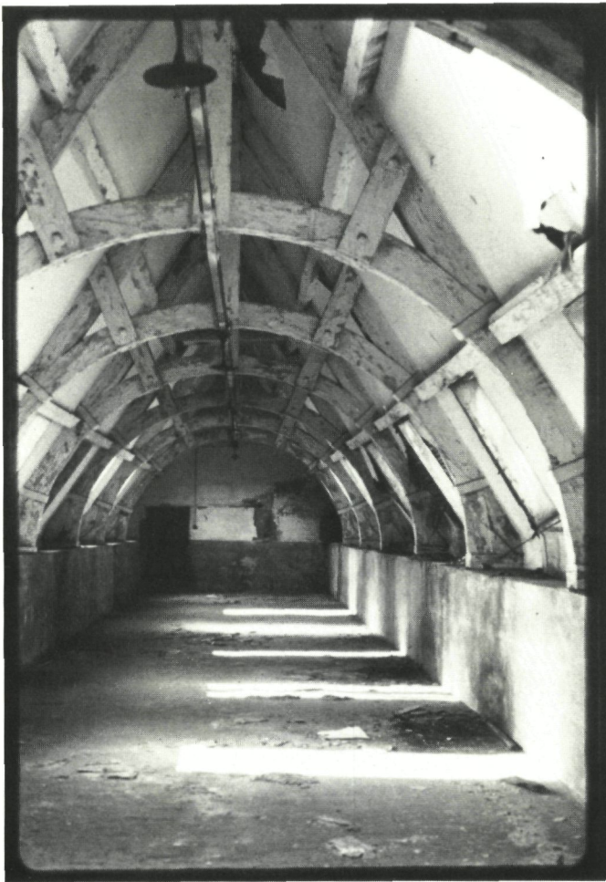
Dakconstructie boven het centrale deel van het complex (foto NHIBS)
