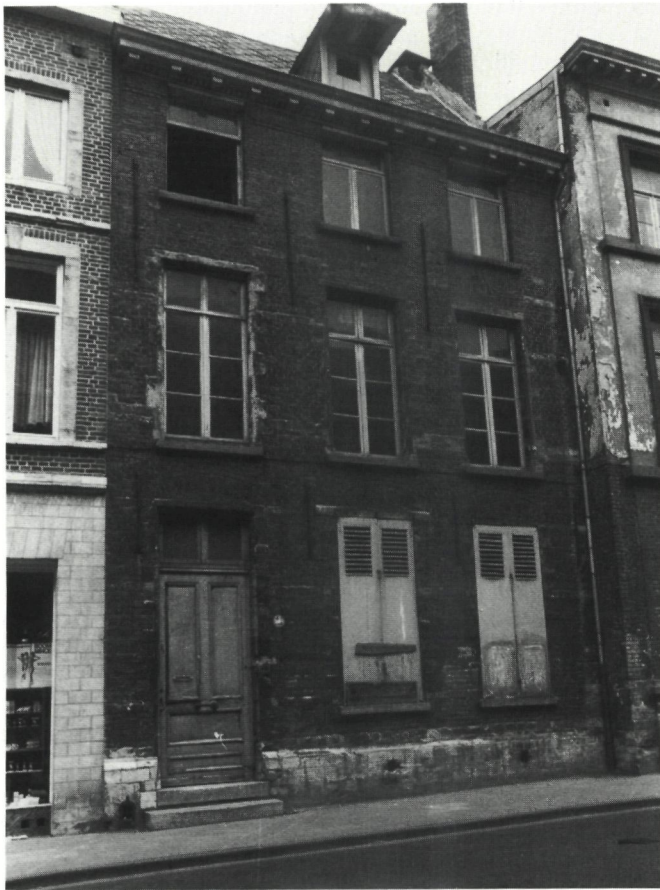
Hierboven : de straatgevel van het huis „van de vrouwe van Spagne” in zijn verbouwde vorm ; ontlastingssysteem, speklagen, vensterstijlen en een duidelijke bouwnaad aan de rechterdeurstijl laten vermoeden dat het om een tot lijstgevel verbouwde trappevel gaat. Dit gebeurde op het einde van de 18de eeuw, waarbij toen de oude ordonnantie onder een bepleistering verdween, zodat de gevel er toen homogeen en overeenkomstig de tijdsmode uitzag. Het diephuis werd aan de straatkant een langshuis (foto MLZ, 1979).
