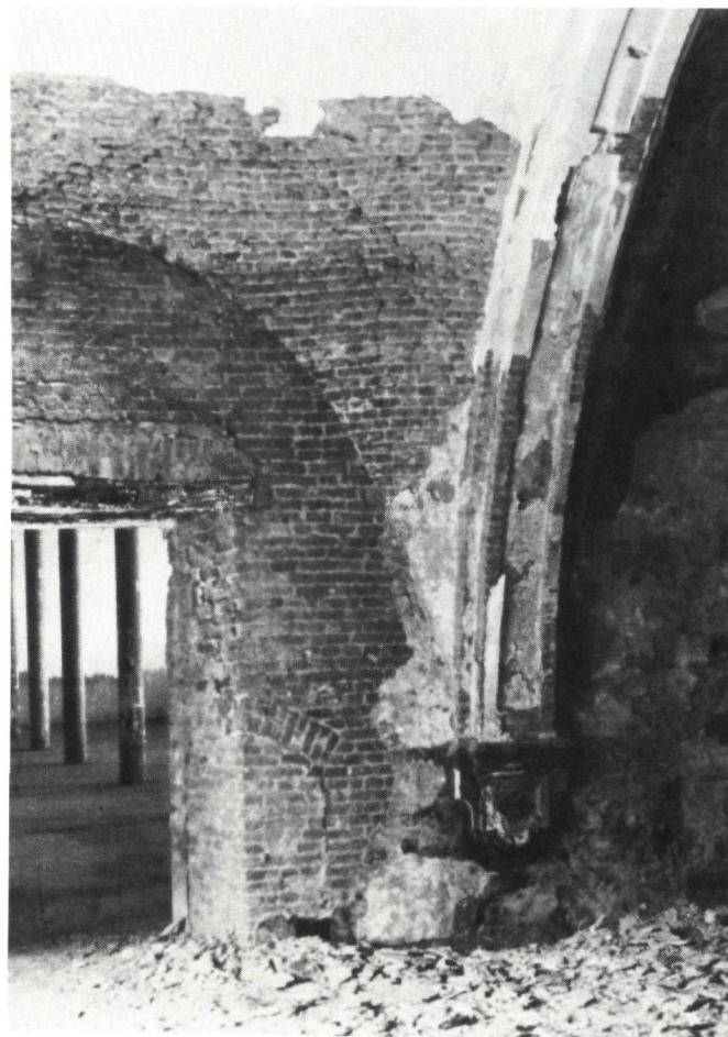
Sacristie, detail van de gewelfaanzet (foto NHIBS)
