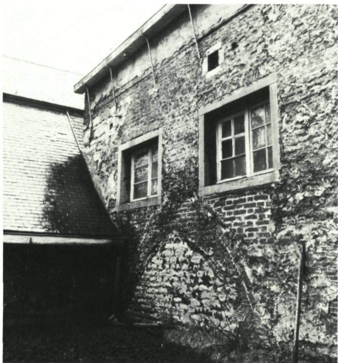
Boven : tijdens de opsporingen werden restanten van 2 kolommen gevonden.
