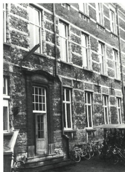
De binnenkoergevel van Van Veens vleugel (nr. 9) behoudt de kenmerken van de traditionele bak- en zandsteenstijl. In 1755 werd hij van een nieuwe deuromlijsting voorzien en de 20ste eeuw voegde er een derde bouwlaag met platdak aan toe (foto MLZ, 1979).
