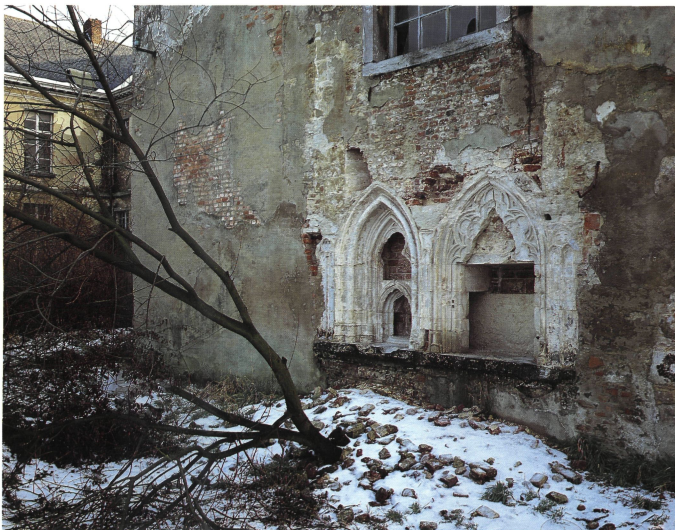
Twee gotische nissen ontdekt in de zuidelijke muur van het koor (foto G. Charlier)
