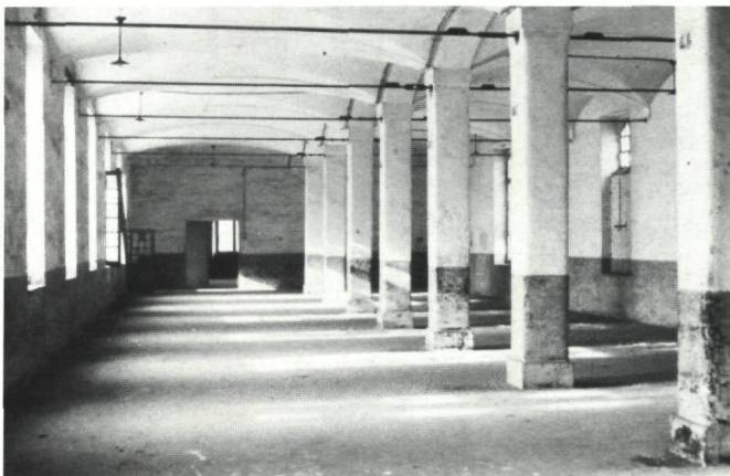
Zuidvleugel : nieuwe vloerconstructie in baksteen (foto NHIBS)
