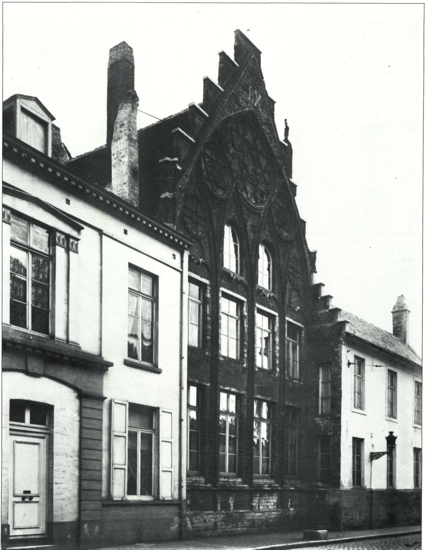
Naast de gotische gevel, de nieuwe gevel van 1818 van het toenmalige poortgebouw ; de gevelbepleistering, de poortomlijsting, het bekronend venster met fronton en kapiteeltjes met lichte empire-inslag zijn conform de tijdsmode. Of het om een nieuwe gevel dan wel om een nieuwe bouw gaat is, wegens de sloping en vervanging door het café Le Relais in 1935, niet meer te achterhalen (foto ACL, 1914-1918).
