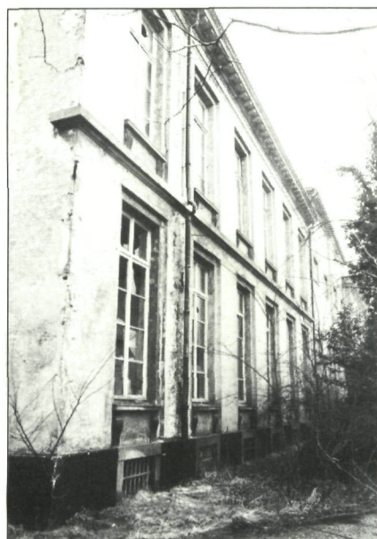
De zuidkant van de oostgevel (foto NHIBS)
