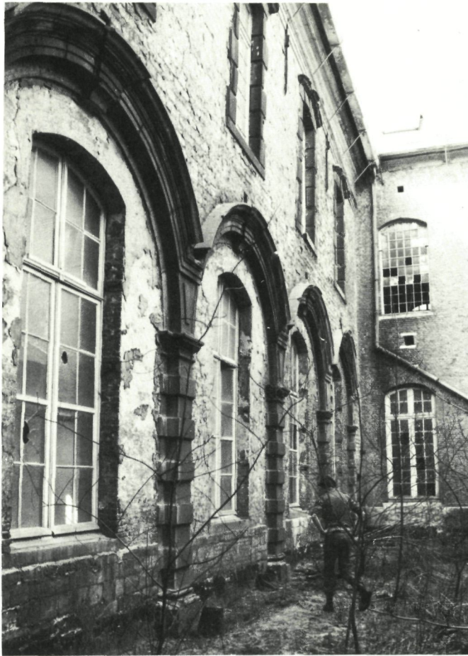
Arcade aan zuidoostgevel van de westvleugel. (Foto M.L.Z.)
