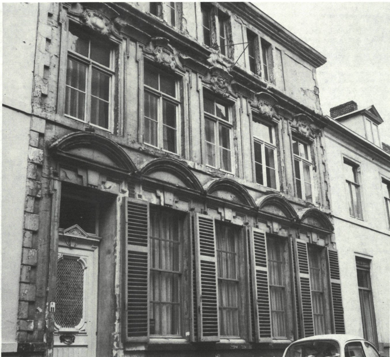
Brugge, Hoedenmakersstraat 11; toestand vóór restauratie. (Foto R.M.L.Z.)
