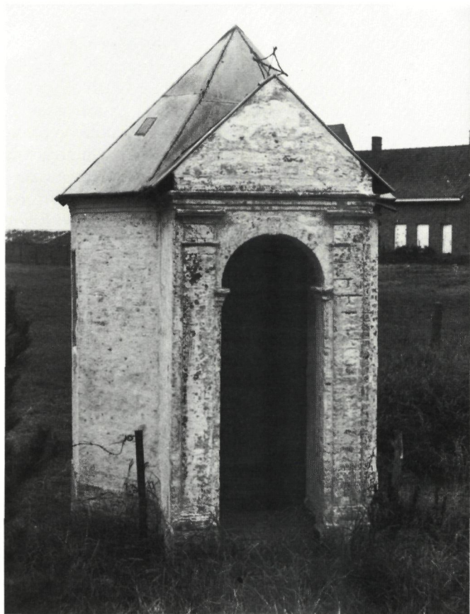
Veurne, wegkapel aan de Nieuwpoortkeiweg.
