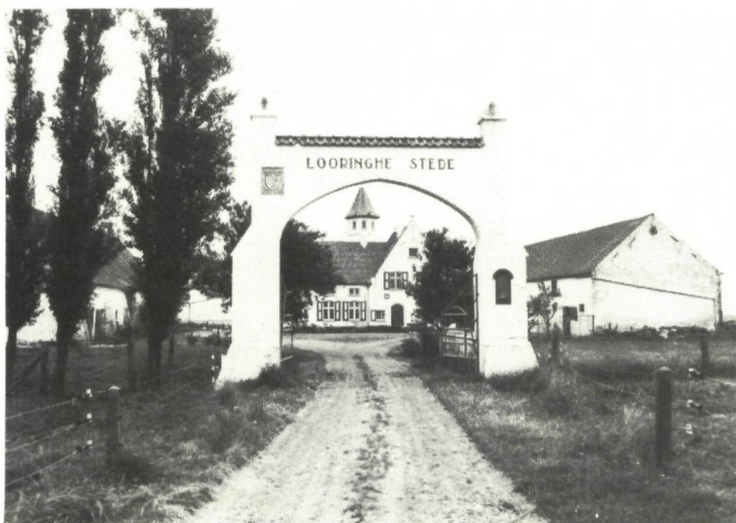
Veurne, Torreelhoek, nr. 1. Inrijpoort van een wederopgebouwde hoeve (foto R.M.L.Z.).
