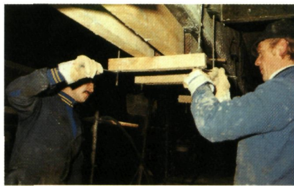
Uitwendig gelijmde wapening
