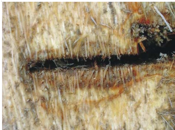
Fig. 6. Aspecto do tecido em torno do furo, após injeção de inseticida .
