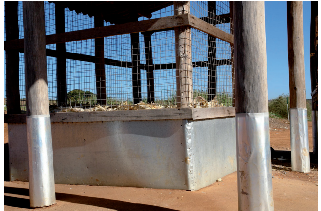
Figura 5. Barreiras de chapa metálica como proteção para entrada de roedores no paiol.
