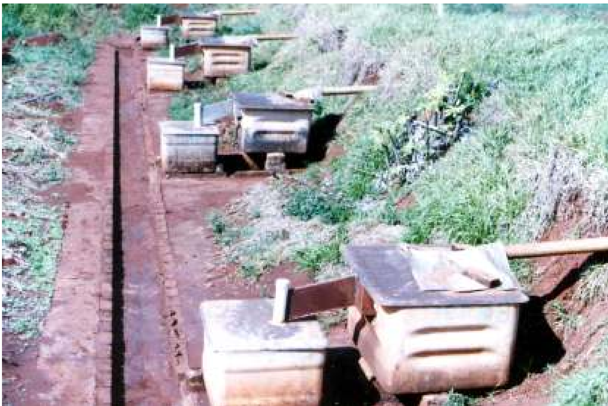
FIG. 3. Sistema coletor de enxurrada, vista parcial.
