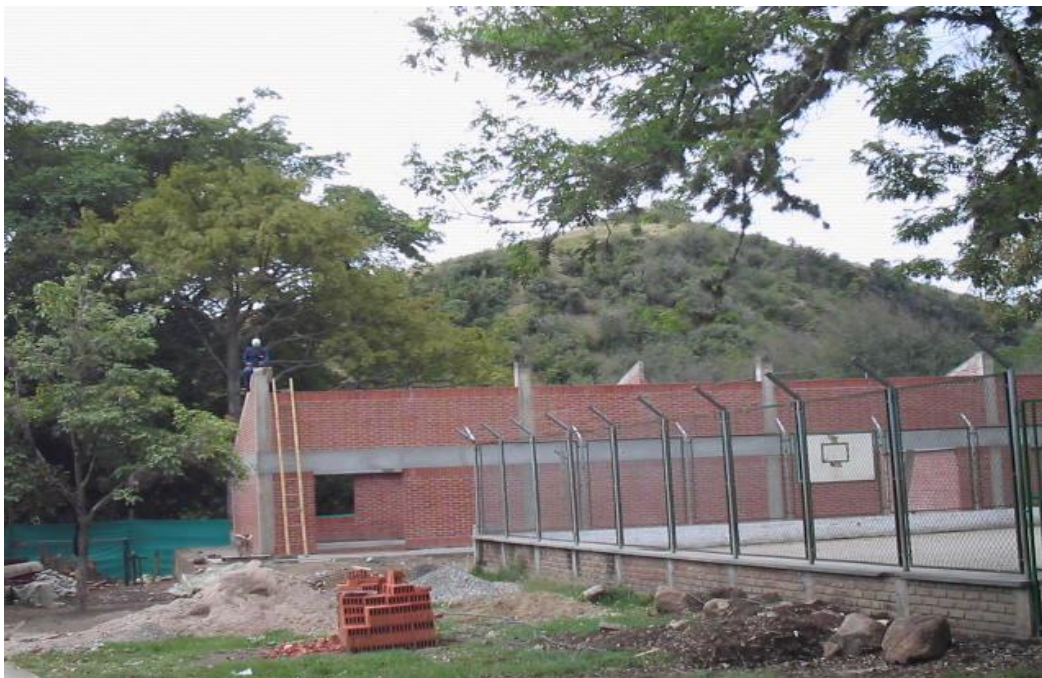
Figura 12. Quiroz, I. (Archivo personal) Obra en construcción aulas
