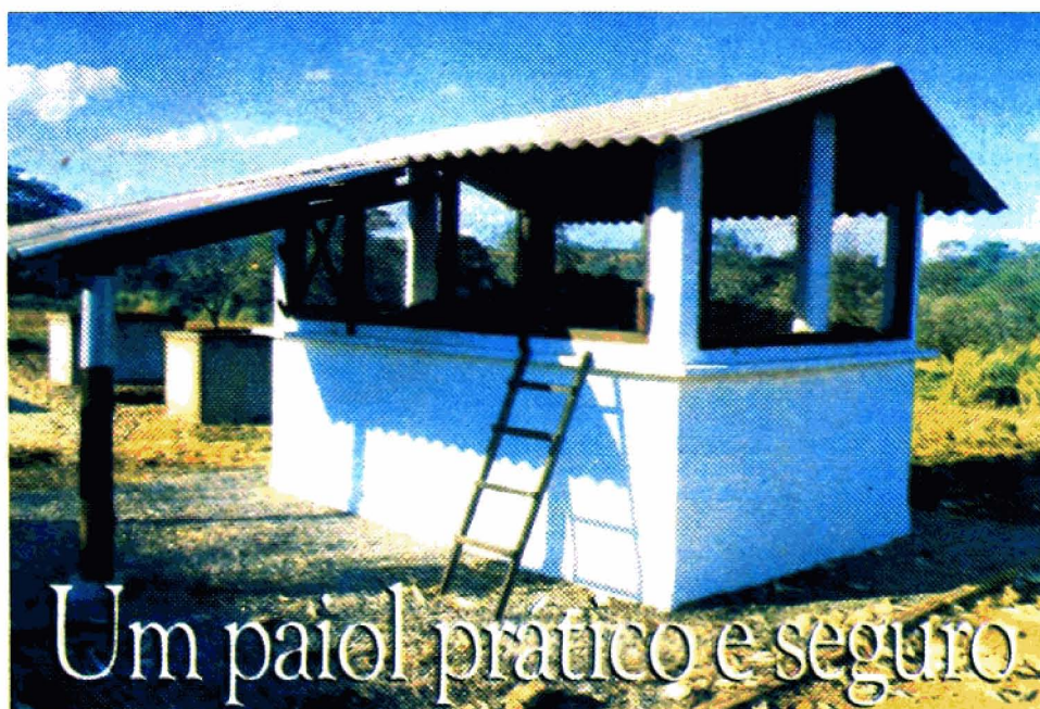
Figura 17. Paiol “Rei-do-Mato”; o rato não entra e o expurgo do milho é realizado em seu interior.
