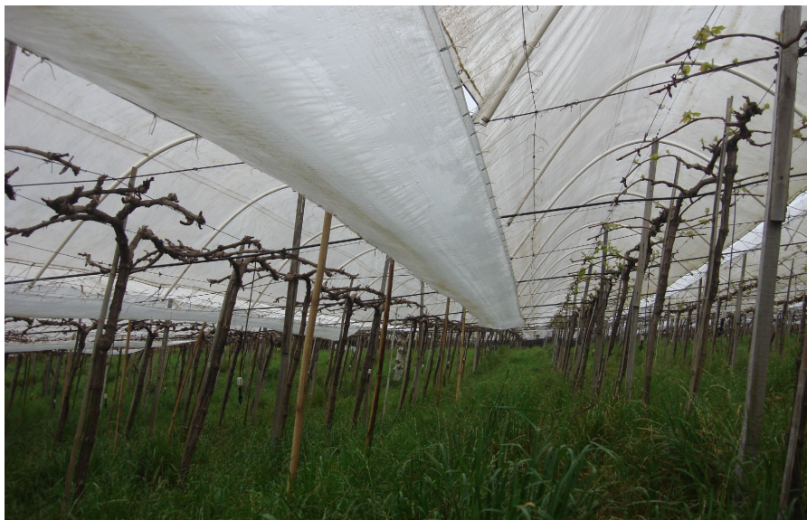
Figura 8. Detalhe de uma calha de plástico disposta no espaço entrelinha, recebendo a água escoada das coberturas dispostas sobre as linhas. Essa calha foi instalada com a função de retirar o excesso de água da chuva do parreiral, porém pode ser usada com cortes longitudinais apenas para conduzir o escoamento da água sem causar respingos na vegetação e nos cachos situados sob as coberturas da linha.
