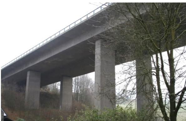
Bild 5.3: Brückenansicht von unten
