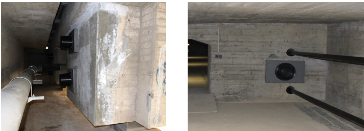
Bild 5.6: Verankerung der externen Spannglieder am Endquerträger (links) und am ersten Stützquerträger (rechts)
