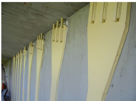
Bild 4.9: Mit einem Korrosionsanstrich versehene Schublaschen (links) und Verankerungsdetail einer Querkraftverstärkung in der Fahrbahnplatte (rechts) [ScHe16]
