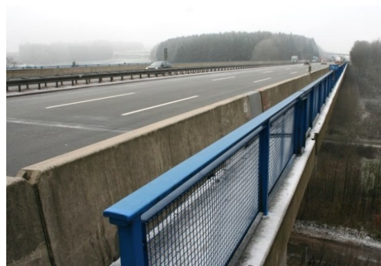
Bild 5.4: Brückenansicht von oben
