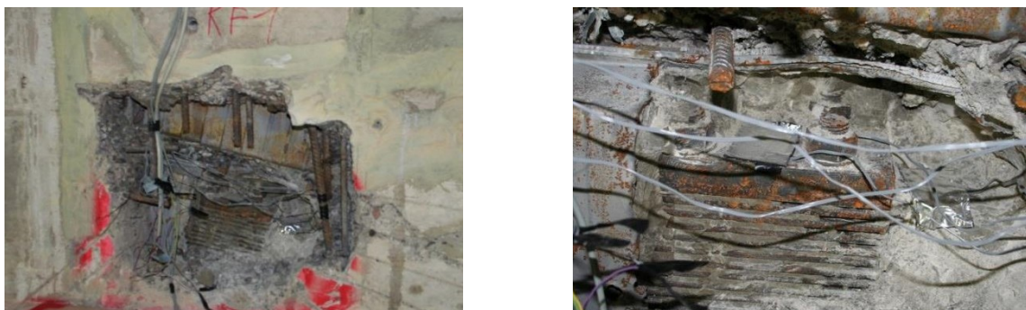
Bild 5.13: Freigelegter Koppelanker (links) und applizierte DMS (rechts)
