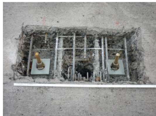
Bild 4.9: Mit einem Korrosionsanstrich versehene Schublaschen (links) und Verankerungsdetail einer Querkraftverstärkung in der Fahrbahnplatte (rechts) [ScHe16]
