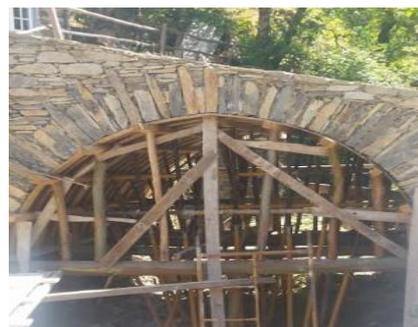
**Figura 29** Construção de um arco para passagem pedonal em xisto, Piódão
