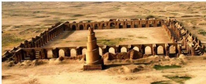
**Figura 30** Mesquita de Samarra, Iraque, construída Sec. IX, muro de tijolo com 10 metros de altura e 2,65 m de espessura, [62]
