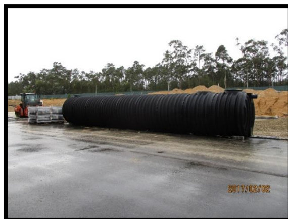
Figura 64 - Fossa séptica pré-fabricada para armazenar as águas residuais
