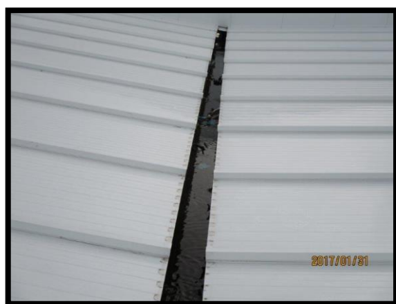
Figura 68 - Caleira pré-fabricada na cobertura
