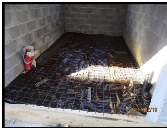
Figura 97 - Colocação de malha sol no pavimento do edifício dos Resíduos Sólidos Urbanos
