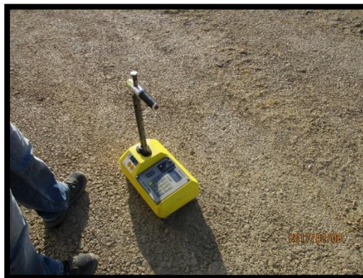
Figura 111 - Ensaio Troxler ao pavimento para aplicação de betuminoso
