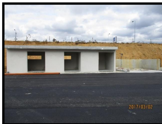
Figura 98 - Revestimento exterior de reboco e pintura no edifício dos Resíduos Sólidos Urbanos
