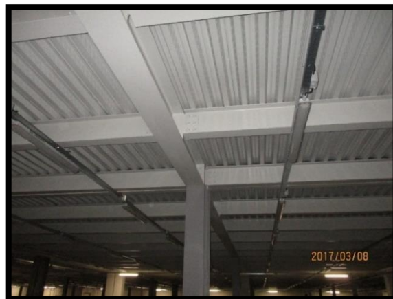
Figura 46 - Acabamento do teto do piso 1
