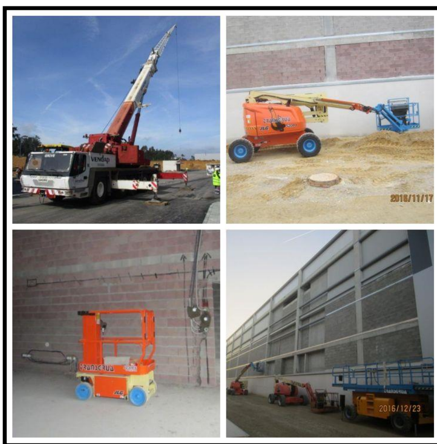
Figura 95 - Registo fotográfico de alguns dos equipamentos presentes em obra
