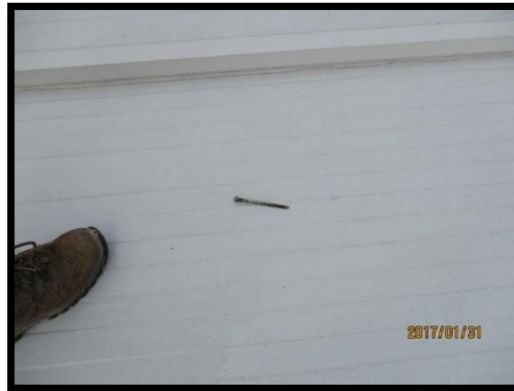
Figura 125 - Identificação de pregos na cobertura
