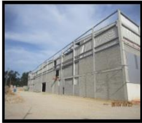
Figura 11- Frente da obra
