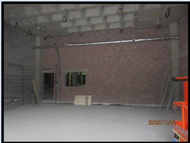
Figura 181 - Gabinete na zona administrativa do piso 0 no início do estágio
