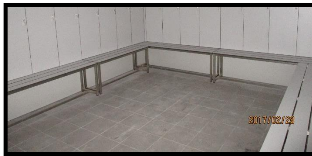
Figura 41 - Aplicação de cerâmico no pavimento dos balneários da zona administrativa
