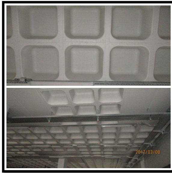
Figura 45 - Pintura do teto do piso 0
