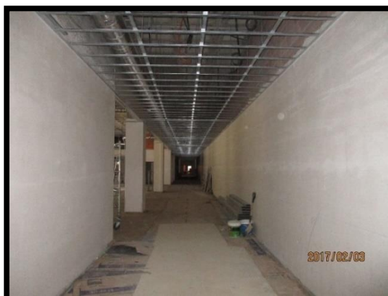
Figura 33 - Pintura da parede do corredor da zona administrativa
