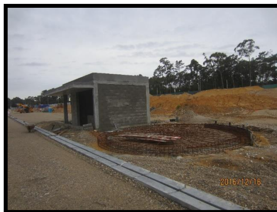
Figura 100 - Construção do edifício do grupo de bombagem e montagem da armadura do reservatório de apoio do grupo de bombagem de segurança contra incêndio em edifícios
