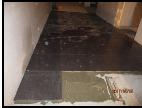
Figura 40 - Aplicação de cerâmico no pavimento do corredor da zona administrativa
