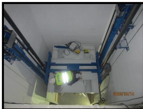
Figura 85 - Montagem dos monta-cargas
