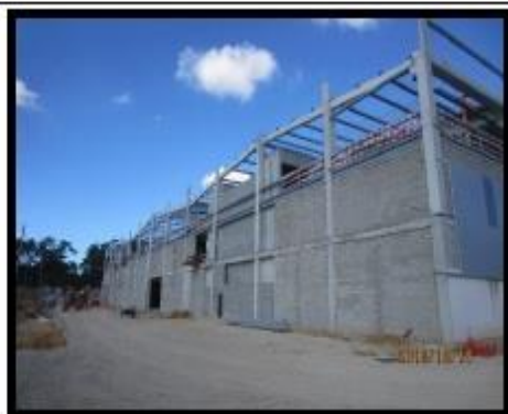
Figura 1 - Frente da obra
