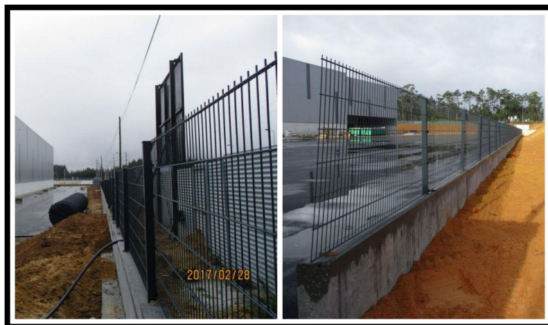
Figura 21 - Aplicação da rede metálica encimada no muro de betão
