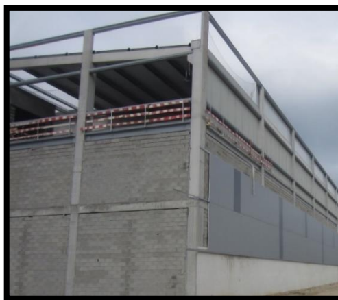
Figura 144 - Utilização de guardas de proteção coletiva na periferia da obra
