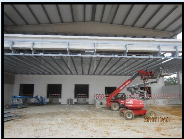
Figura 185 - Zona de cargas e descargas no cais no início do estágio
