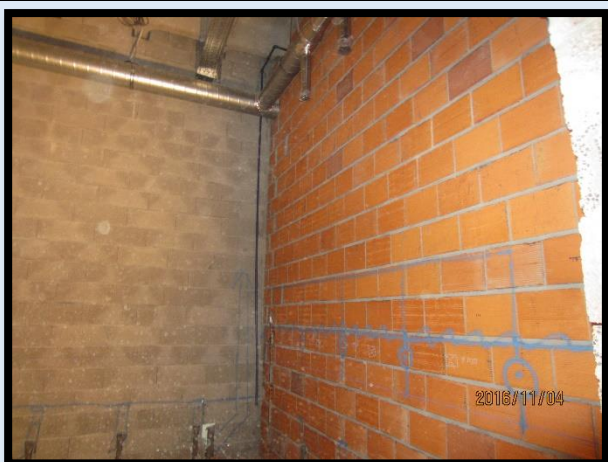
Figura 171 - Balneários da zona administrativa do piso 0 no início do estágio
