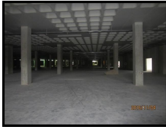
Figura 37 – Acabamento do pavimento em betão à vista do piso 0
