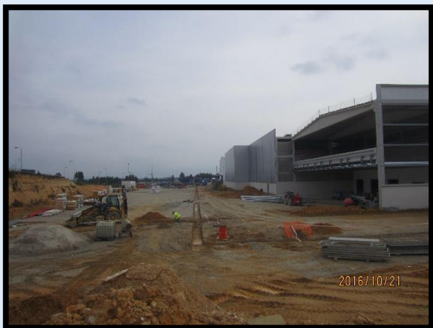
Figura 161 – Edifício dos Resíduos Sólidos Urbanos no início do estágio
