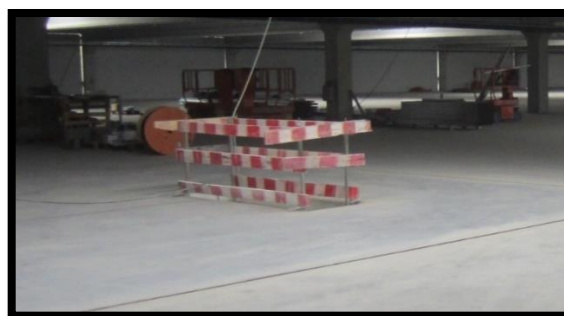
Figura 142 - Utilização de guardas de proteção coletiva nos negativos do piso 2
