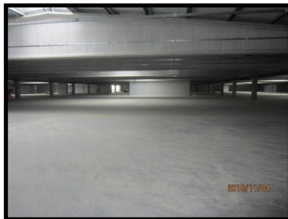
Figura 39 - Acabamento do pavimento em betão à vista do piso 2
