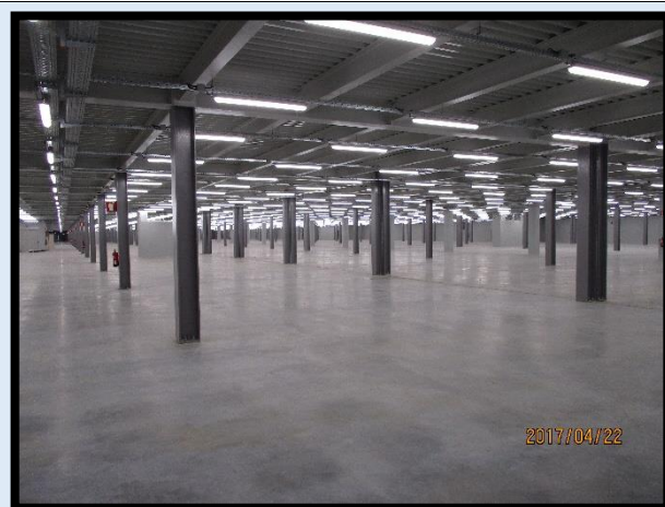
Figura 190 - Parte do armazém do piso 1 no fim do estágio
