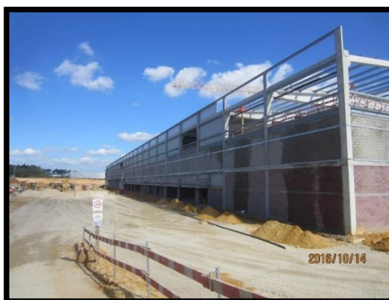
Figura 25 - Alvenaria de bloco térmico aplicada até ao piso 1 no início do estágio
