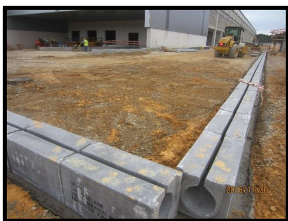
Figura 67 – Continuação da montagem da caleira de balão pré-fabricada da rede de drenagem de águas pluviais
