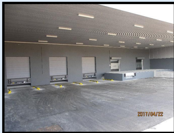
Figura 168 - Interior do cais de cargas e descargas no fim do estágio
