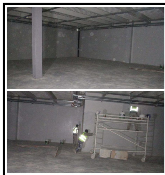
Figura 30 - Pintura na parede do piso 1
