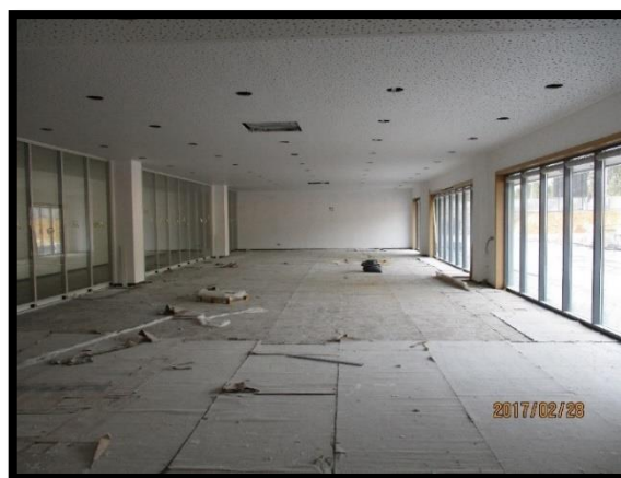
Figura 50 - Aplicação do pladur acústico no teto do refeitório da zona administrativa
