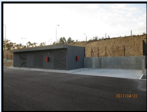
Figura 162 - Edifício dos Resíduos Sólidos Urbanos no fim do estágio
