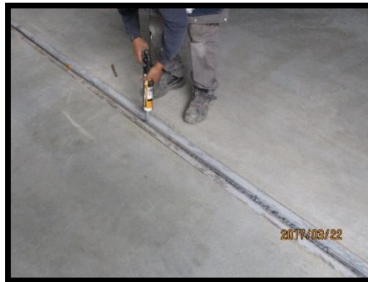
Figura 108 - Aplicação do mástique corta-fogo
