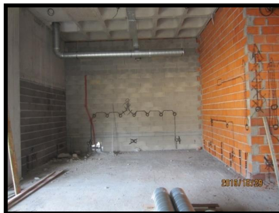
Figura 55 - Marcação da abertura de roços para a passagem da rede de abastecimento de água
