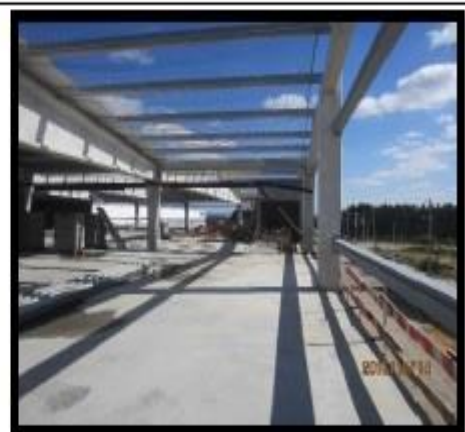
Figura 10 - Piso 2 (Acabamento da cobertura)
