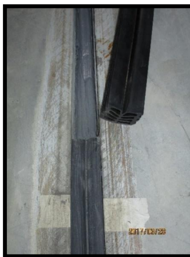
Figura 109 – Aplicação da junta de expansão para pavimentos térreos
