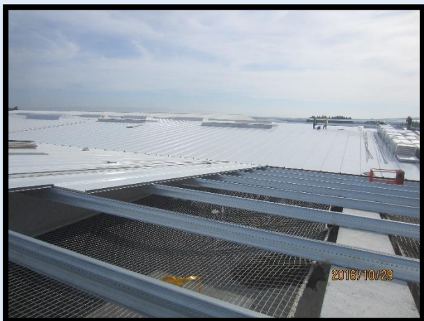
Figura 197 – Continuação da construção da cobertura no início do estágio
