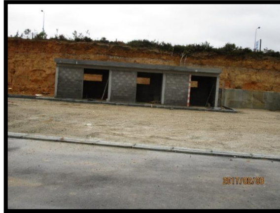
Figura 96 - Construção do edifício dos Resíduos Sólidos Urbanos
