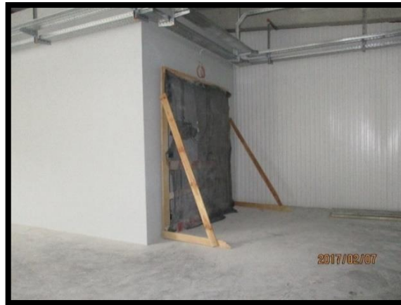
Figura 143 - Utilização de guardas de proteção coletiva e rede protetora nos negativos dos monta-cargas
