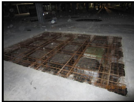
Figura 23 - Construção da laje fungiforme do piso 1 no negativo da grua
