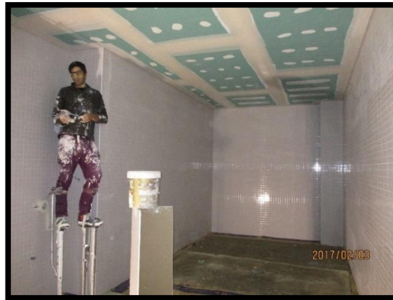
Figura 51 - Aplicação do pladur hidrófugo no teto dos balneários na zona administrativa
