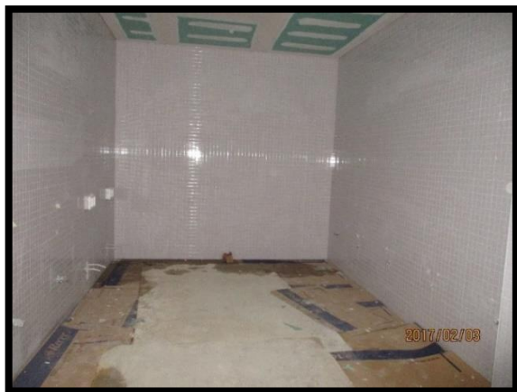
Figura 34 - Aplicação de cerâmico nas paredes dos balneários
