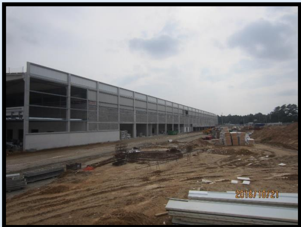
Figura 163 - Edifício do Grupo de Bombagem no início do estágio
