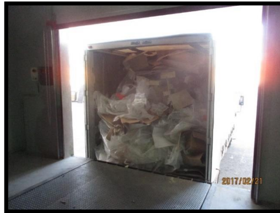
Figura 149 - Carga de resíduos provenientes da obra
