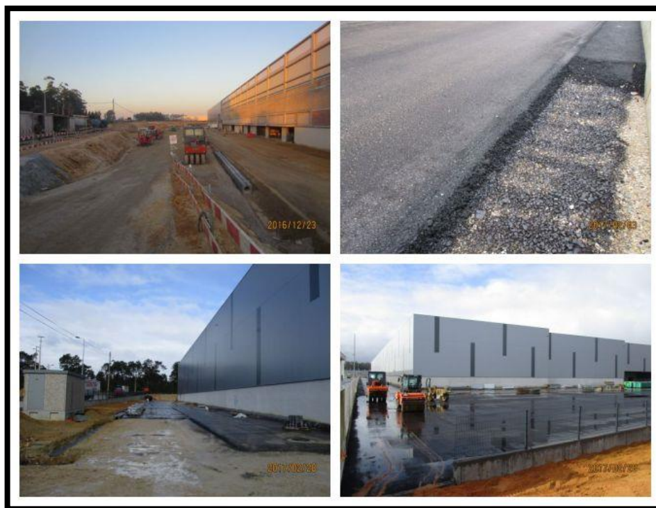
Figura 17 - Evolução da execução do pavimento betuminoso
