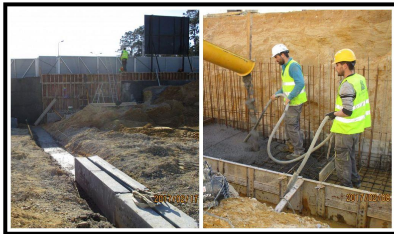
Figura 20 - Cofragem e betonagem da sapata e do muro de suporte
