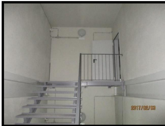
Figura 32 - Pintura das paredes e teto das caixas de escada
