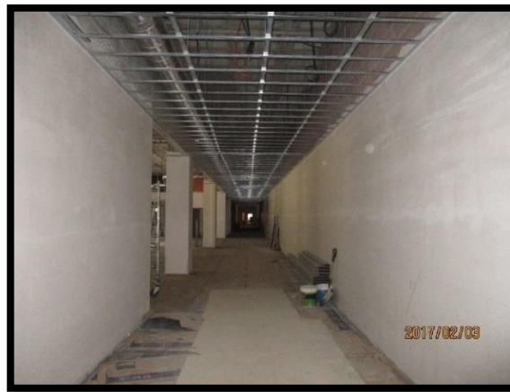
Figura 48 - Montagem da estrutura para a aplicação do pladur acústico no teto do corredor da zona administrativa
