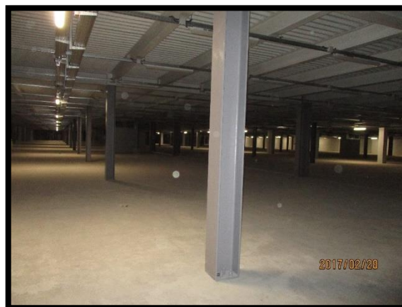
Figura 53 - Pintura corta-fogo nos pilares metálicos do piso 1
