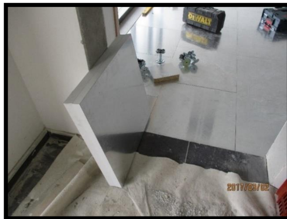
Figura 42 - Acessórios do piso flutuante para aplicação no pavimento da zona administrativa
