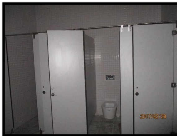
Figura 60 - Instalação de loiças sanitárias (sanitas e urinóis)
