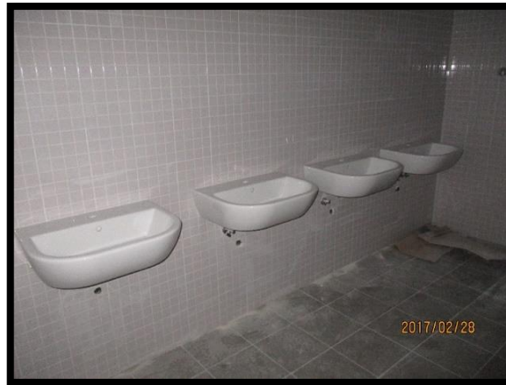
Figura 59 - Instalação de loiças sanitárias (lavatórios)
