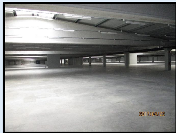
Figura 192 - Parte do armazém do piso 2 no fim do estágio
