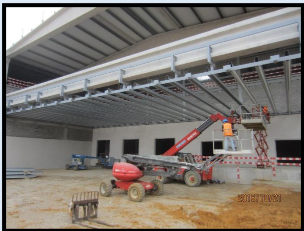
Figura 167 - Interior do cais de cargas e descargas no início do estágio
