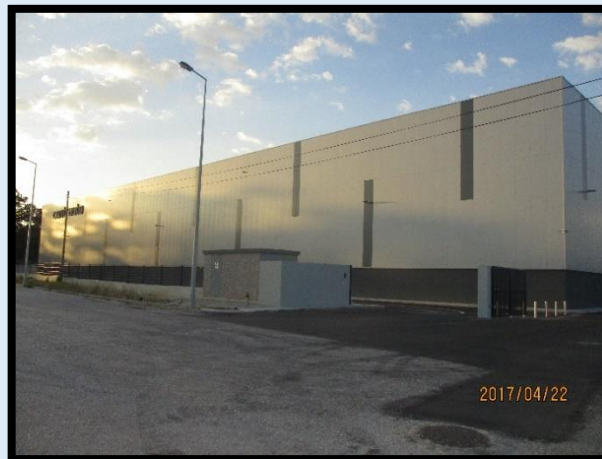
Figura 152 - Frente de obra no fim do estágio
