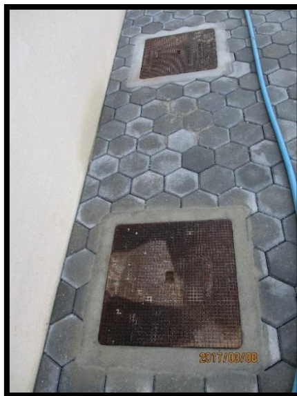
Figura 62 - Aplicação de caixas de visita da rede de drenagem de águas residuais
