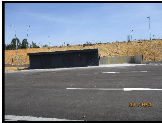
Figura 99 - Edifício dos Resíduos Sólidos Urbanos concluído
