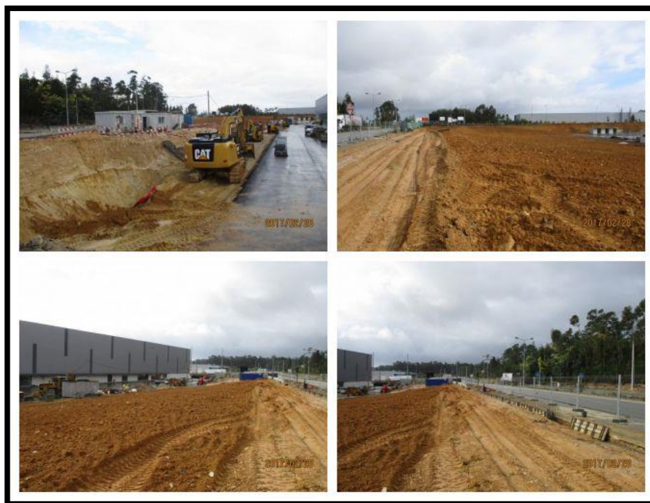
Figura 16 - Movimento de terras no final de fevereiro, 2017
