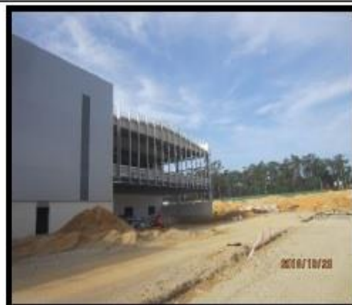
Figura 14- Zona do cais
