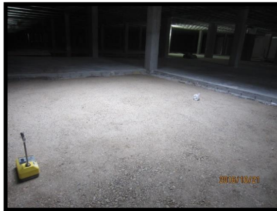
Figura 22 - Piso térreo onde a base da grua se encontrava
