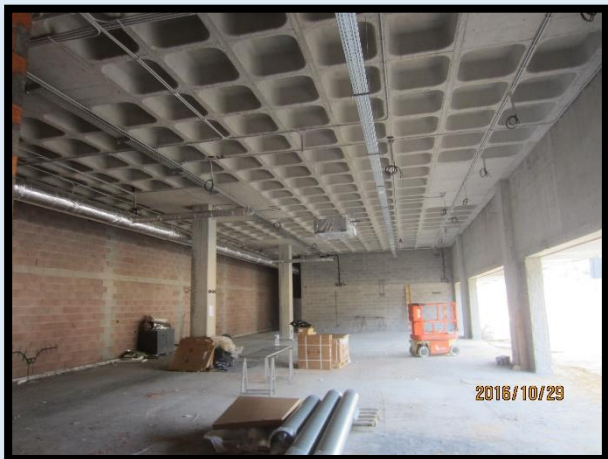
Figura 175 - Refeitório da zona administrativa no piso 0 no início do estágio
