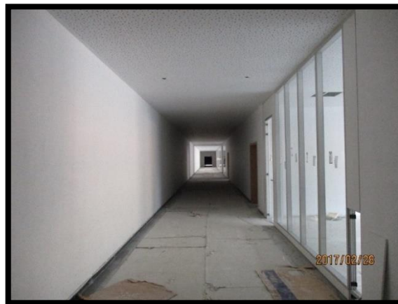
Figura 49 - Aplicação do pladur acústico no teto do corredor da zona administrativa
