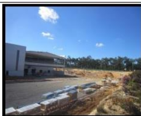
Figura 4 - Zona do cais
