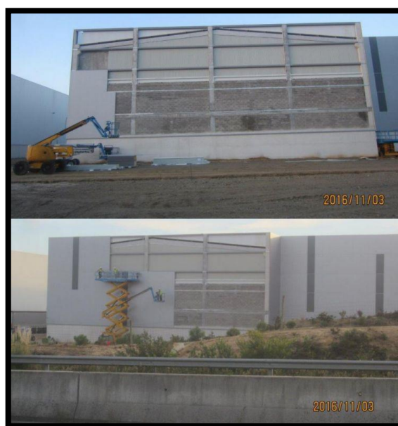
Figura 26 - Aplicação do painel exterior
