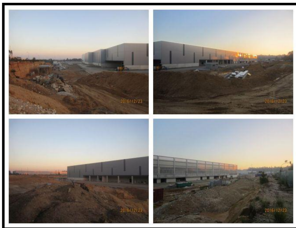
Figura 15 - Movimento de terras no final de dezembro, 2016
