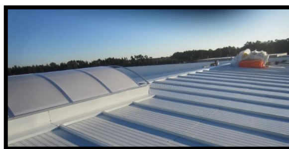
Figura 28 - Montagem das claraboias de iluminação zenital
