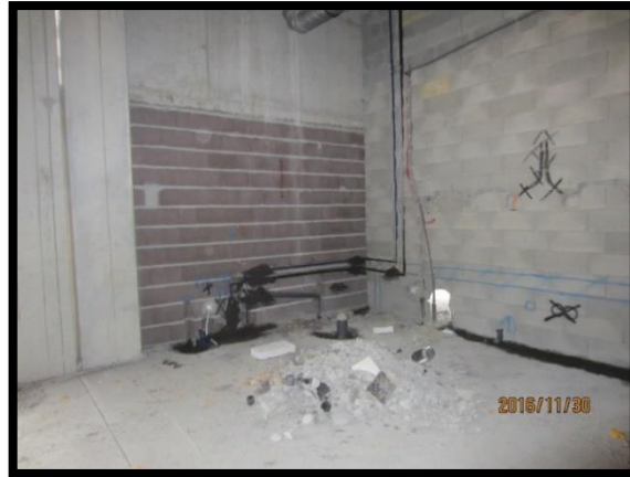
Figura 61 - Montagem da rede de drenagem de águas residuais
