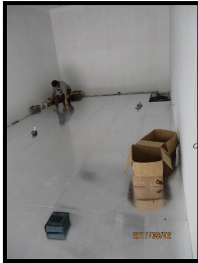
Figura 43 - Aplicação de piso flutuante no gabinete do dono de obra na zona administrativa
