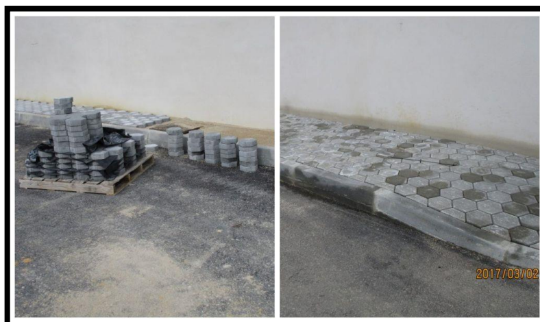
Figura 18 - Execução dos passeios em betão do tipo pavê
