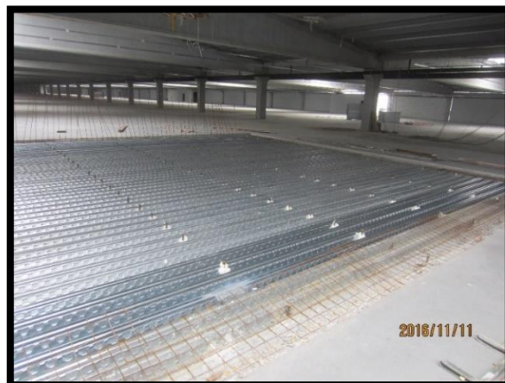
Figura 24 - Construção da laje colaborante do piso 2 no negativo da grua
