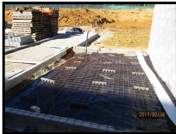
Figura 102 - Montagem da armadura para os dois depósitos de apoio do grupo de pressurização
