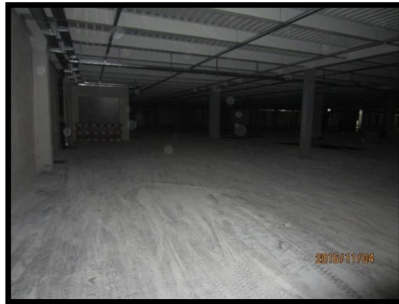
Figura 38 - Acabamento do pavimento em betão à vista do piso 1
