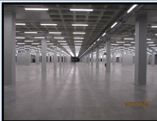
Figura 184 - Parte do armazém do piso 0 no fim do estágio
