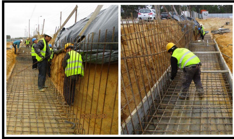
Figura 19 - Colocação da armadura na sapata e no muro de suporte
