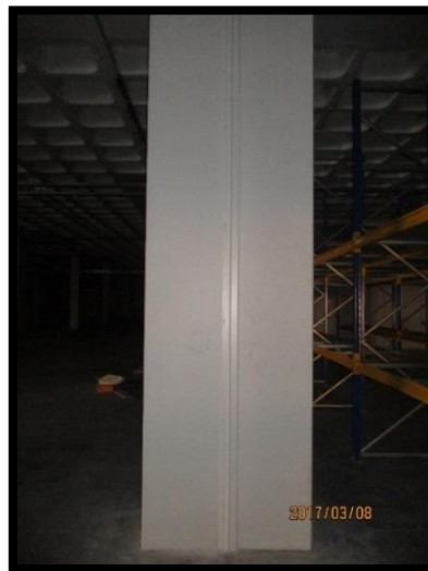
Figura 52 - Pintura dos pilares pré-fabricados no piso 0
