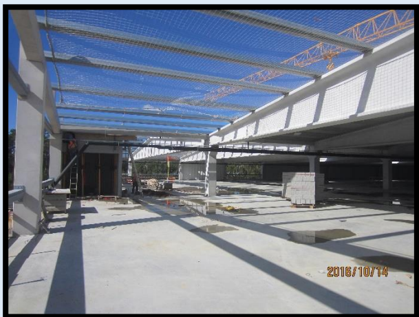
Figura 191 - Construção da cobertura no piso 2 no início do estágio
