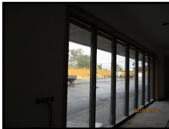
Figura 73 – Aplicação de vãos envidraçados na zona administrativa para a zona exterior
