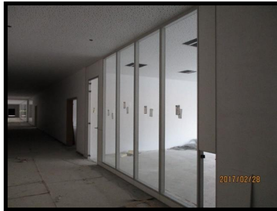
Figura 71 - Montagem de divisórias envidraçadas no corredor da zona administrativa
