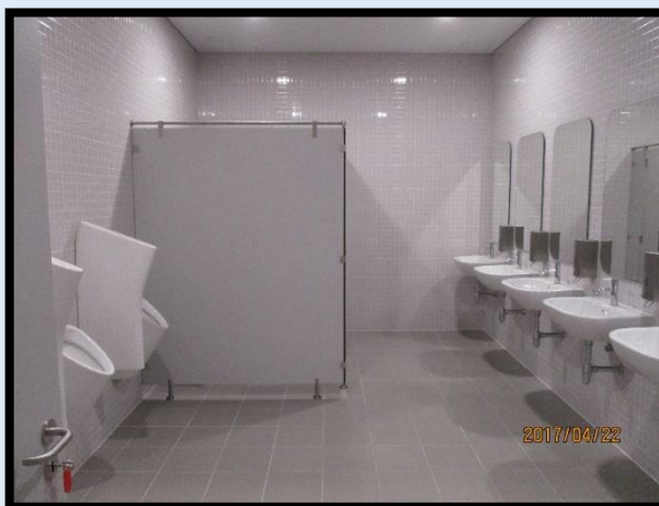
Figura 174 - Instalações sanitárias na zona administrativa do piso 0 no fim do estágio
