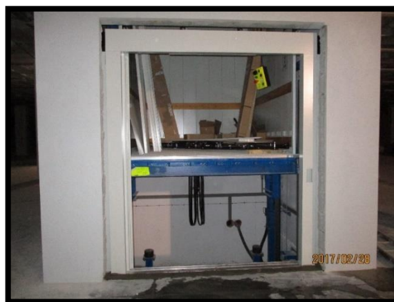
Figura 87 – Continuação da montagem dos monta-cargas
