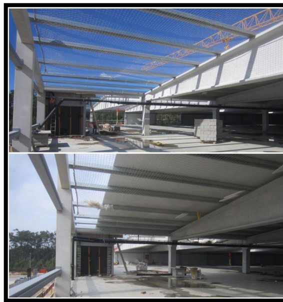
Figura 27 - Aplicação do painel de cobertura do tipo sanduíche
