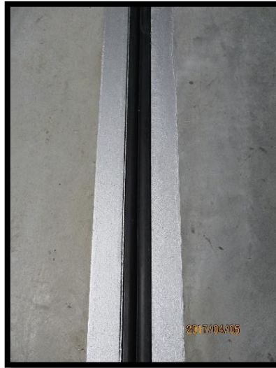
Figura 110 - Junta de dilatação com o acabamento final de pintura
