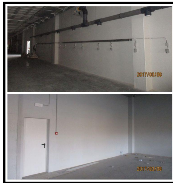
Figura 29 - Pintura na parede do piso 0
