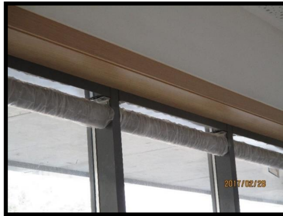
Figura 74 - Montagem de estores nos vãos envidraçados da zona administrativa
