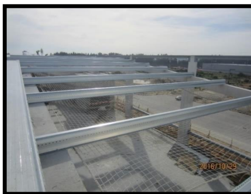
Figura 145 – Utilização de rede protetora na aplicação do painel de cobertura
