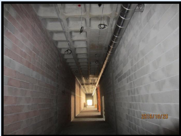
Figura 169 - Corredor da zona administrativa no piso 0 no início do estágio
