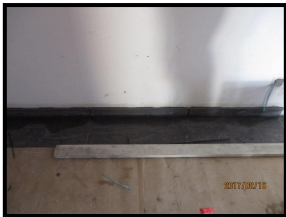
Figura 36 - Aplicação do rodapé no corredor da zona administrativa
