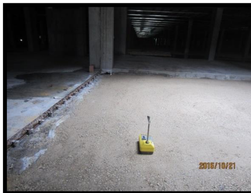
Figura 112 - Ensaio Troxler para construção do piso térreo no negativo da grua
