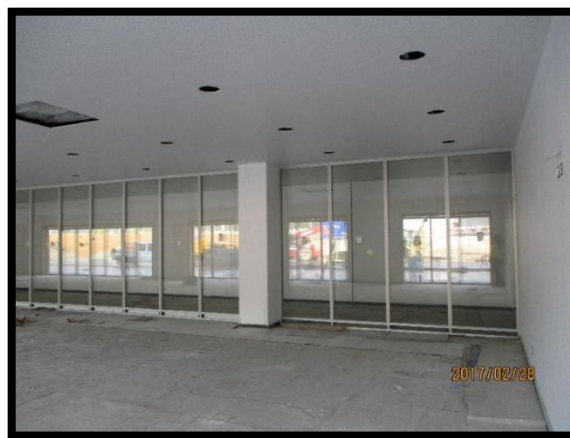
Figura 72 – Montagem de divisórias envidraçadas no refeitório da zona administrativa
