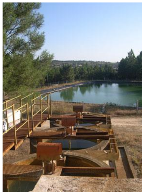
Figura 5 - Aspeto de uma estação de tratamento de águas ácidas da mina da Cunha Baixa (Pereira et al., 2013).
