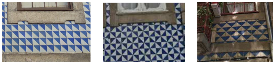
Figura 2: Fotografias de fachadas de três edifícios no Porto, retiradas do googlemaps .
