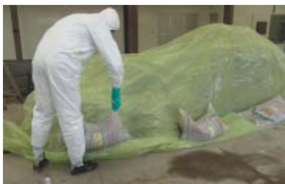
Figura 13. Vedação da lona nas laterais.
