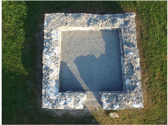
Abb. 8: Schwaderloch-Oberes Bürkli (AG). Mit Hilfe einer Drohne angefertigtes Luftbild des Wachturms nach Abschluss der Sanierung im Jahr 2015. Foto: Foto ArcFlyTech, J. Piech.
