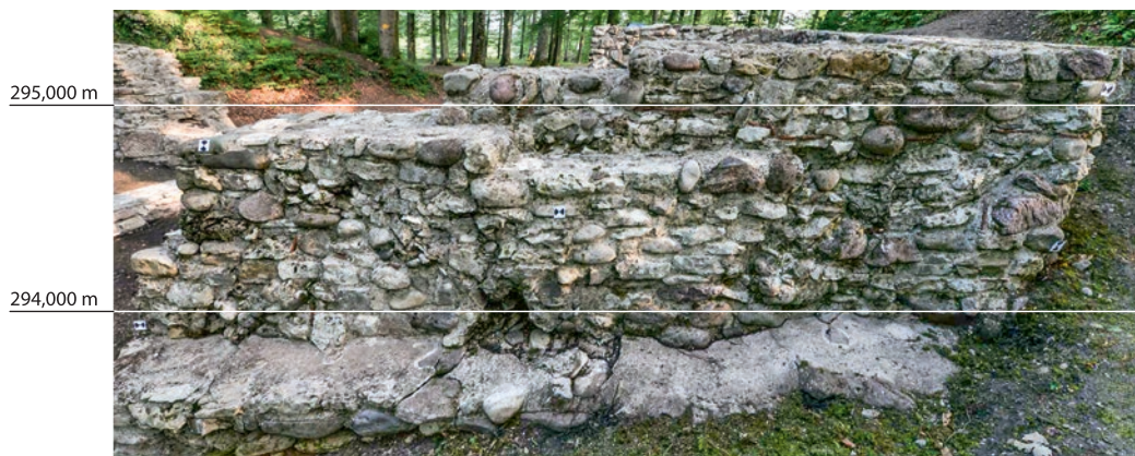
Abb. 22: Möhlin-Riburg/Bürkli (Mol. 014.5). Blick von Süden an M6 (zur Lage vgl. Abb. 21). Der unregelmässige Aufbau des Mauerwerks sowie die nach Süden vorspringende Fundamentplatte lassen den Schluss zu, dass es sich bei M6 höchstwahrscheinlich um den Überrest einer ehemals zweischaligen Mauer handelt, deren Kern aus Erdreich und Steinschutt bestand (vgl. auch Abb. 20; 26). Die äussere (südliche) Mauerschale wurde wahrscheinlich schon vor der vollständigen Freilegung im Jahr 1941 durch Witterungseinflüsse bzw. bei der (neuzeitlichen) Beschaffung von Baumaterial zerstört.
