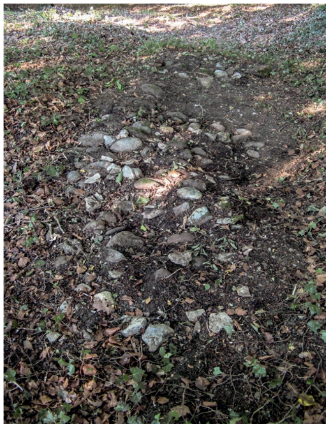
Abb. 17: Möhlin-Riburg/Bürkli (Mol. 014.5). Blick auf die Überreste des vornehmlich aus grossen Kieschwacken bestehenden Fundaments der Nordmauer des Rechteckbaus im Südosten des Hauptplateaus (zur Lage vgl. Abb. 8). Blick nach Osten.
