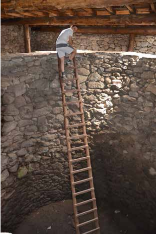
Abb. 16: (Früh-)nezeitliche und moderne Baubefunde, die nachweislich zur Bevorratung von Schnee und Eis dienen. Blick in den frühnezeitlichen pozzo de la nieve von Casillas (E).
