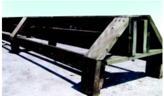
Túnel de ventilação (Vista Lateral).
