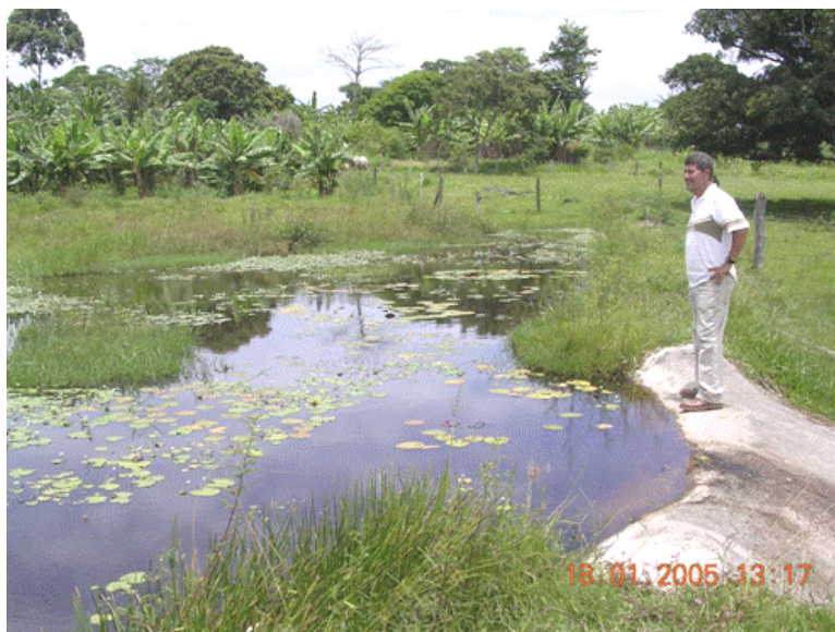
Figura 5: Barragem subterrânea construída em Iguaba Grande-RJ.
