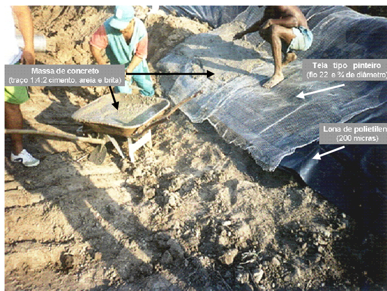
Figura 4: Detalhe da construção do vertedouro.
