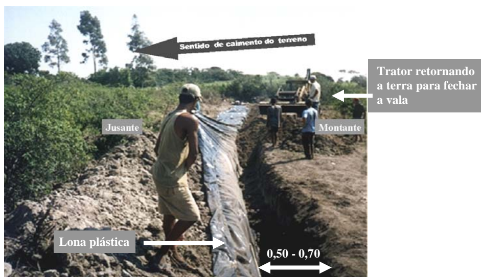
Figura 3: Fechamento da vala.
