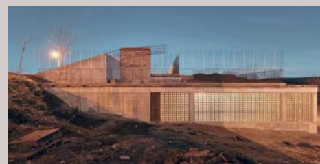
Vista notturna dell'edificio da ovest. ©Aitor Estévez
