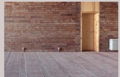
Vista della pavimentazione interna in tavelle laterizie. ©Aitor Estévez
