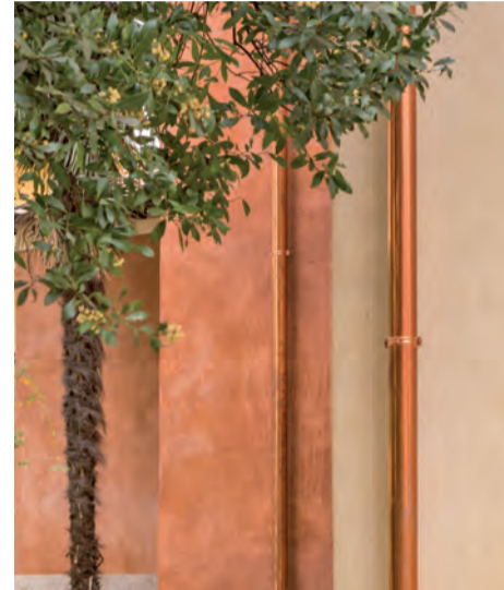
La colorazione rossa dei due corpi edilizi su strada ha portato a una ricerca di malte di finitura specifiche. Il cocchiopesto è stato il riferimento iniziale per le mescole di finiture e d'intonaco di corpo.
