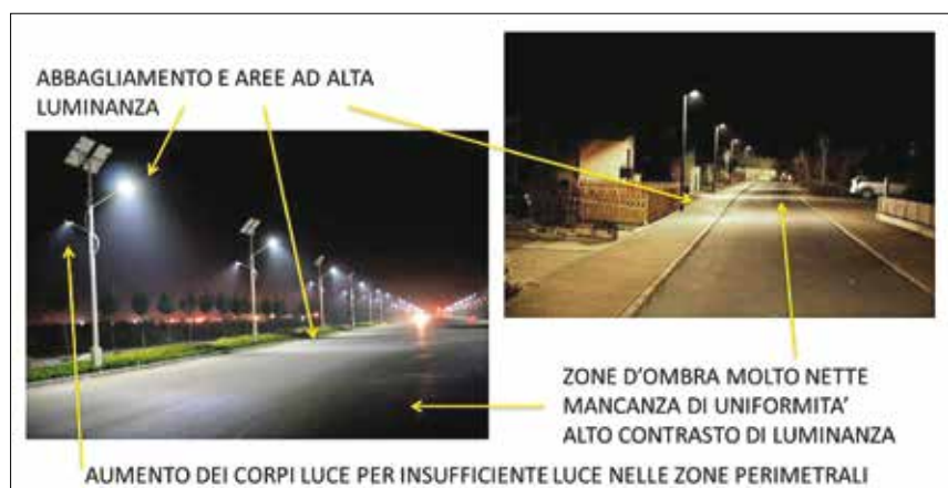
6. Casi di errata riprogettazione o sostituzione con nuova illuminazione
