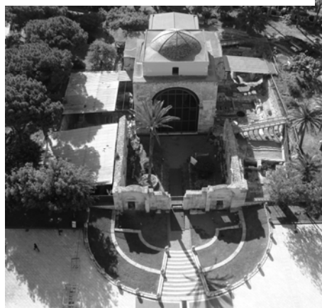
Fig. 2. La copertura a San Saturnino, Cagliari
