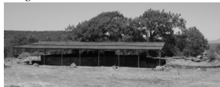
Fig. 3. La copertura a Su Monte
