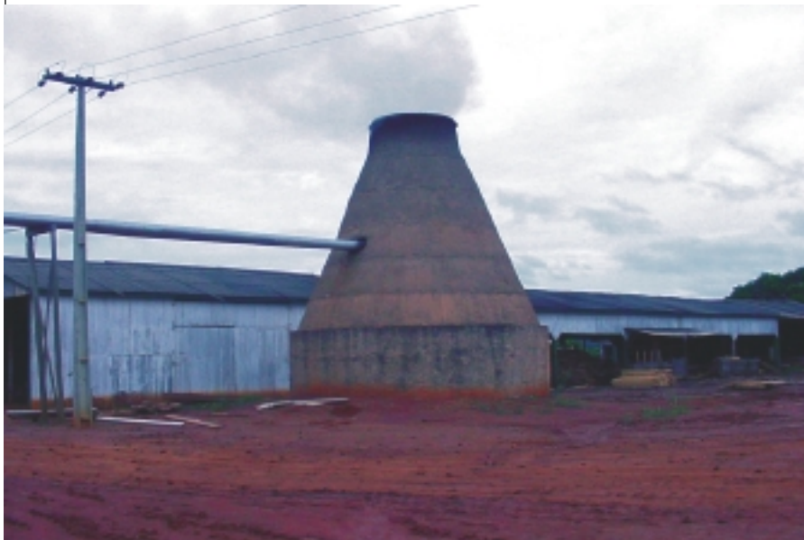
Fig. 8. Forno de incineração de resíduos dos tipos serragem e maravalhas.
