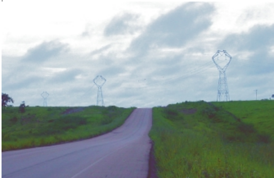
Fig. 4. Linha de transmissão ao longo da rodovia BR-364 interligando o sistema elétrico do Acre ao de Rondônia.
