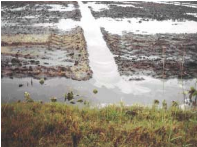
Figura 17. Dreno interno da lavoura sem escoamento devido às más condições de drenagem do dreno coletor externo. Embrapa Clima Temperado, 2004.
