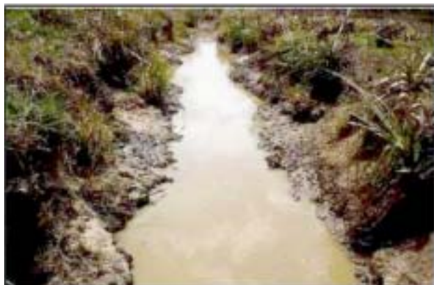
Fig. 2. Dreno coletor-principal componente da macro drenagem em área de várzea.
