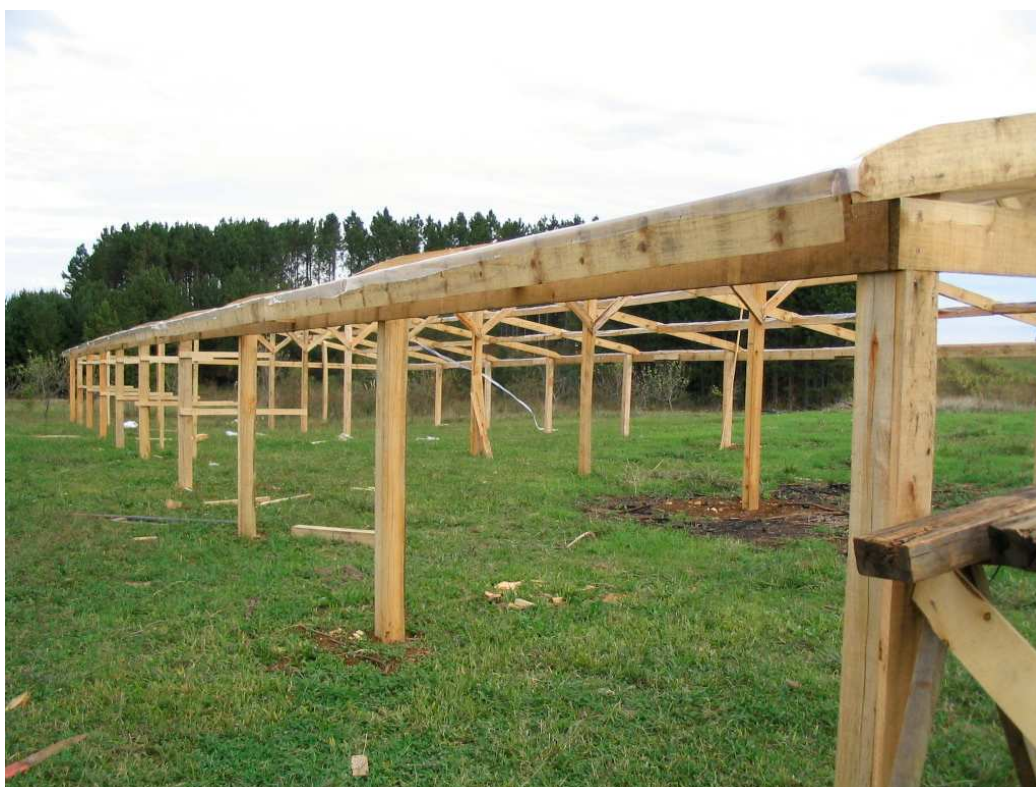
Fig. 1. Estufa construída em madeira.
