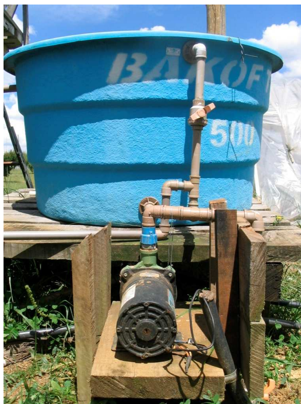
Fig. 9b. Detalhe da moto-bomba ligada ao reservatório.
