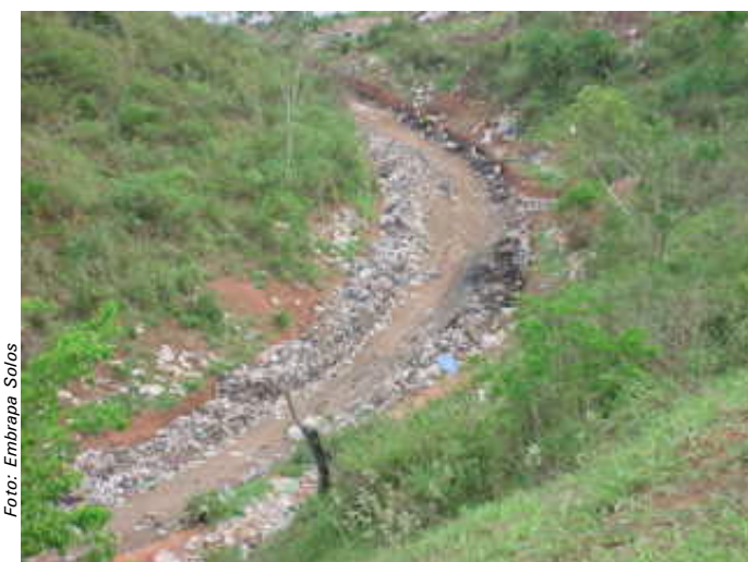
Fig. 76. Local de entrada dos caminhões, onde o lixo encontra-se espalhado, sendo levado pelo vento até as propriedades vizinhas.
