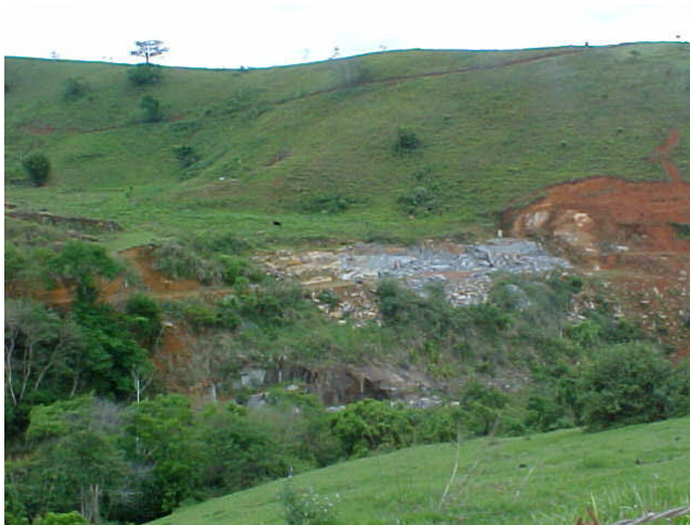
Fig. 48. Pedreira de extração de rocha da unidade Varre Sai, na encosta de morro a beira de drenagem, com rejeitos acumulados em terreno com alta declividade, próximo a São Sebastião da Boa Vista.
