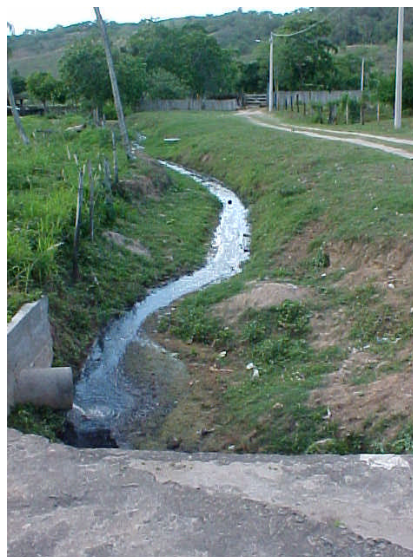
Fig. 29. Córrego com lançamento de esgoto em Boa Ventura. Fonte: Embrapa Solos (2004).
