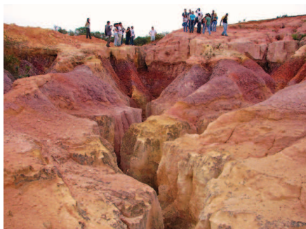
Foto 8 – Erosão laminar e voçoroca, RJ.
