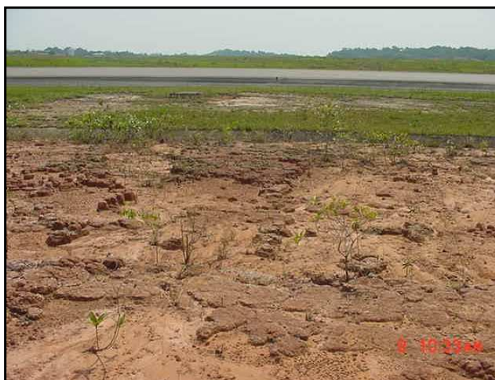
Fig. 2.8. Encrostamento superficial no aeroporto de Manaus-AM.
