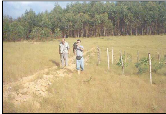
Fig. 5.7. Valeta à montante da voçoroca.
