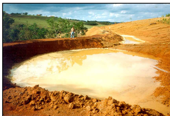
Fig. 5.6. Bacia de Captação.
