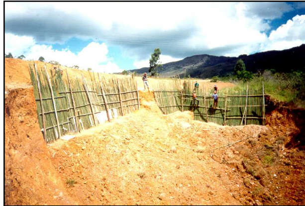
Fig. 5.9. Paliçada na parede da voçoroca.
