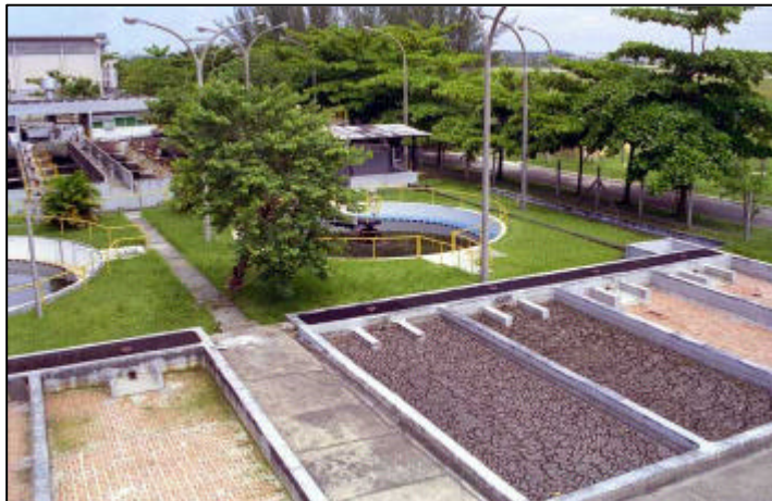
Fig. 1 - Estação de Tratamento de Águas Residuárias do AIRJ.
