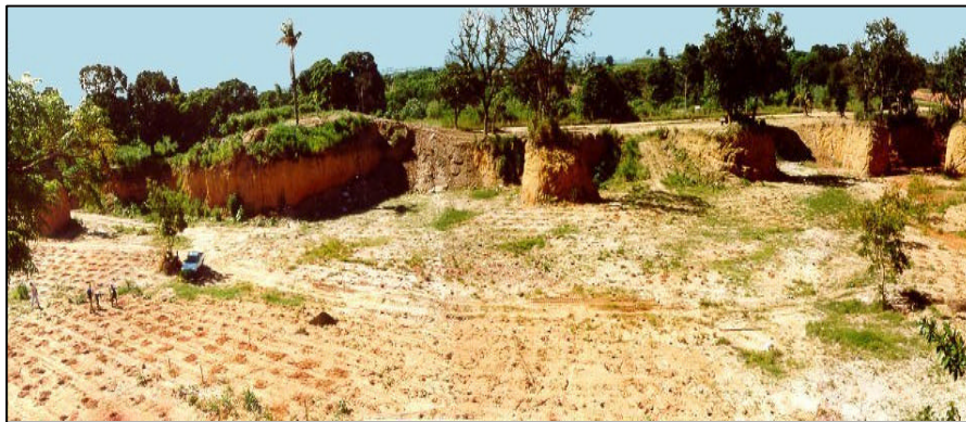
Fig. 3 - Jazida do Itacolomi após limpeza e sistematização do terreno e início do processo de revegetação.
