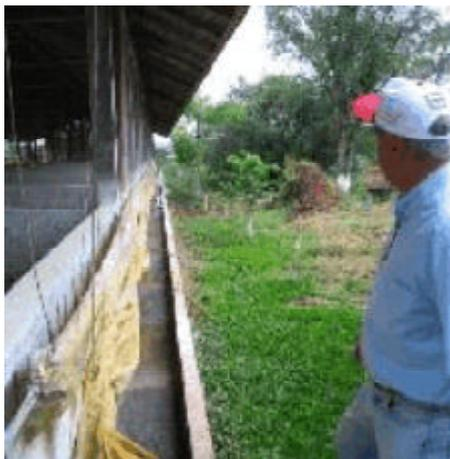
Figura 12. Beiral do telhado com projeção além da canela de coleta dos dejetos (KONZEN, 2003).
