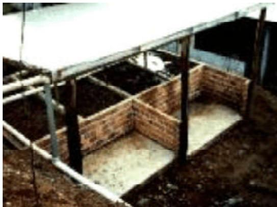
Figura 3. Tipo de cobertura das câmaras de saturação e fermentação (DAI PRÁ, 2003).
