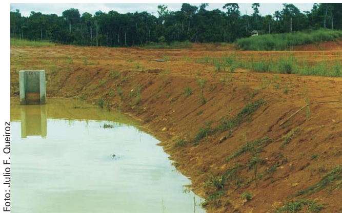
Fig. 3. Erosão do dique e acumulo de sedimentos em suspensão na água de um viveiro de produção de tambaqui em Iquitos no Peru.
