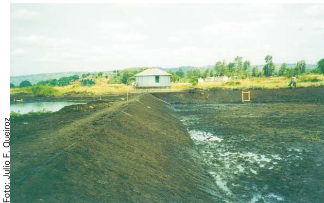
Fig. 2. Vista geral de um viveiro em construção no Quênia na África e detalhe da infiltração da água ao longo de toda a extensão lateral dos diques.
