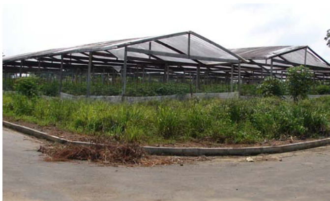
Fig. 7. Casa de vegetação, do tipo guarda chuva, em Silves-AM, com estruturas rústicas de madeira e sem laterais, comum no Estado do Amazonas.
