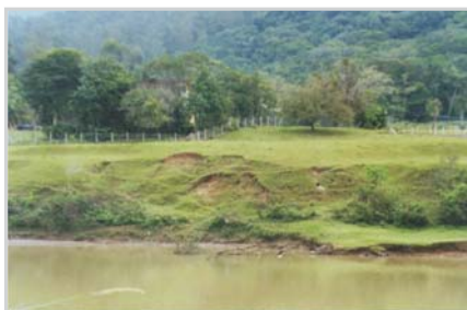
Fig. 4. Margens erodidas; Compartimento Apiúna/Ascurra-Indaial
