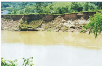
Fig. 6. Erosão de talude por solapamento de base no rio Itajaí-Açu; Compartimento 4; Acurra-Indaial/Gaspar-Apiúna/Acurra-Indaial
