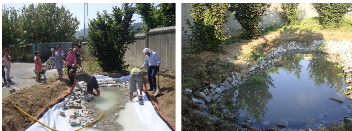
Figuras 14 e 15 - À esquerda charco em construção e à direita acabado de construir.
