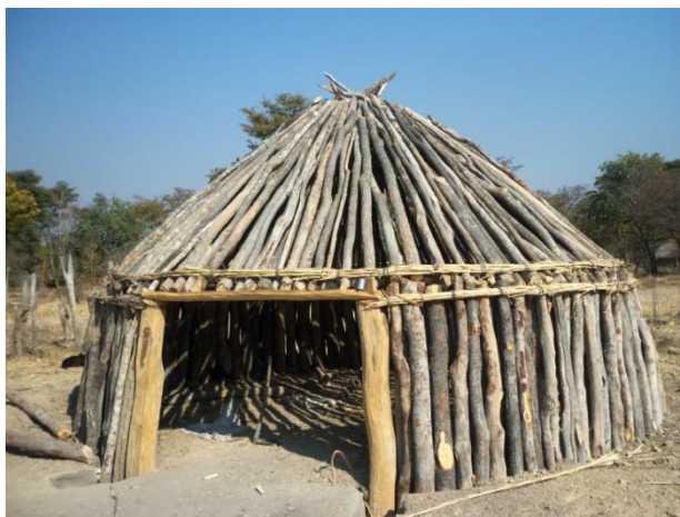
Figura 15 6. Fase da construção de uma casa de pau-a-pique
