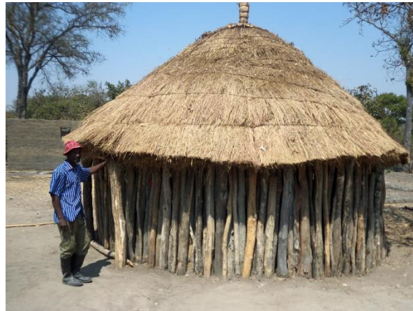
Figura 17 7. Fase final da construção de uma casa de pau-a- pique
