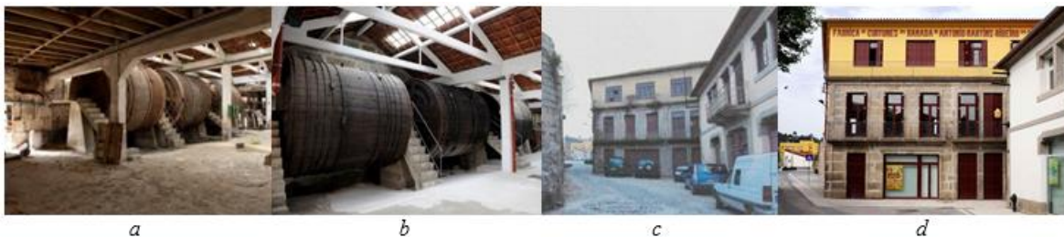
Figura 3. Fábrica da Ramada antes (a) (c) e depois (b) (d) do processo de transformação e reutilização
